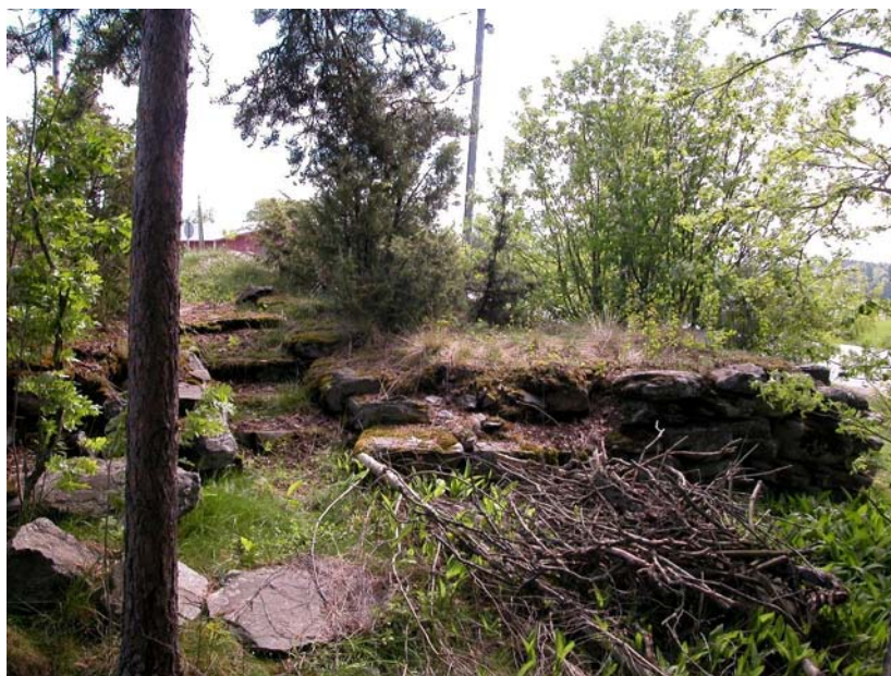
Kuva 11. Rakennuksen kiviperusta Aitolahdentien ja Kaitavedentien risteyksessä. Kuvattu lännestä. Kuvaaja K. Luoto
