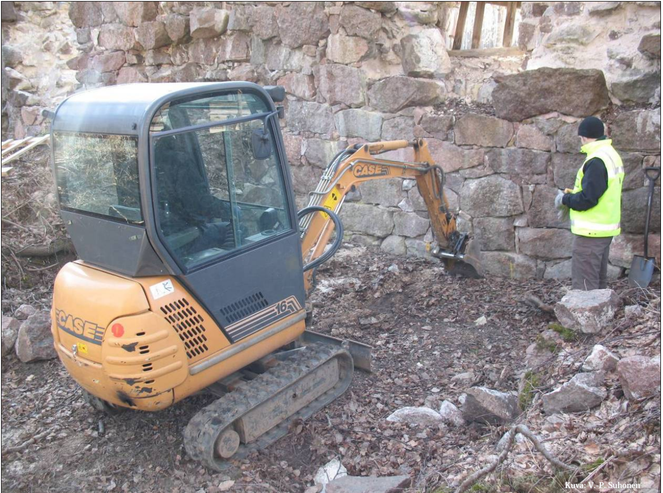
Kuva 3: Bastionin eteläkyljen koeojan 4 kaivaukset käynnissä.
