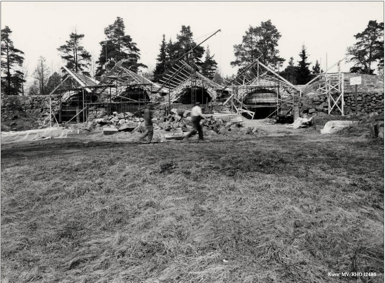
Kuva 5: Bastionin restaurointi käynnissä 1970-luvulla.
