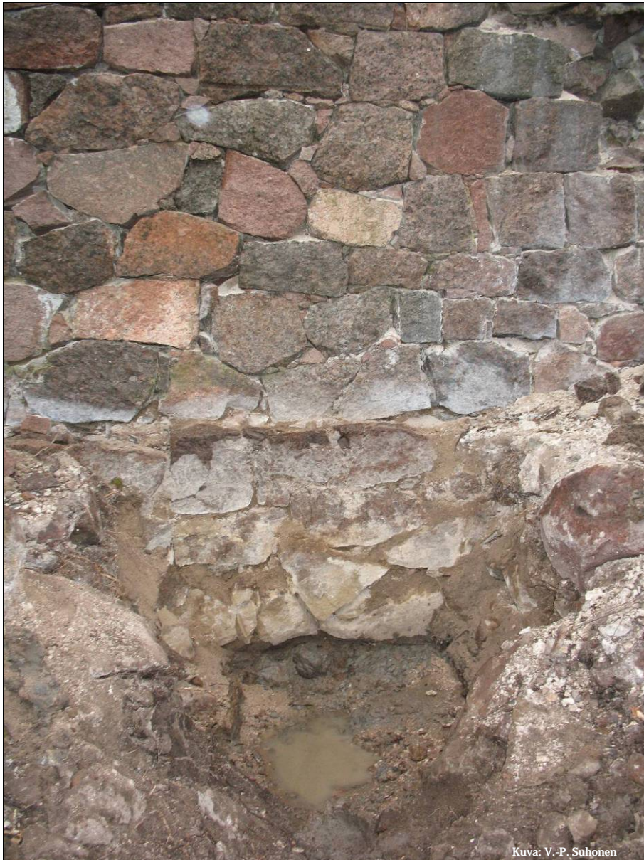
Kuva 17: Eteläkyljen ulkosivun muurin alaiset paalut. Vanhan maanpinnan-taso näkyy selvänä värirajana
