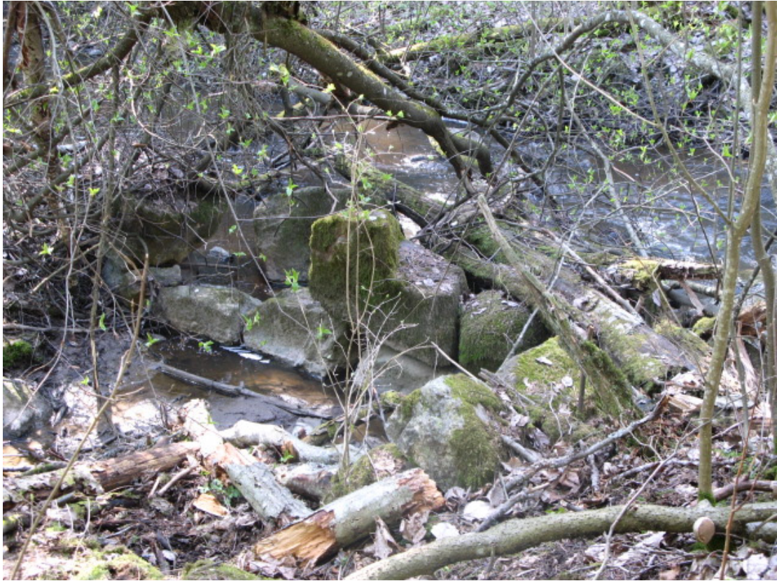
Kuva 40. Myllyn kivrakenteita kuvattuna pohjoisesta. Kuva: Elina Terävä.
