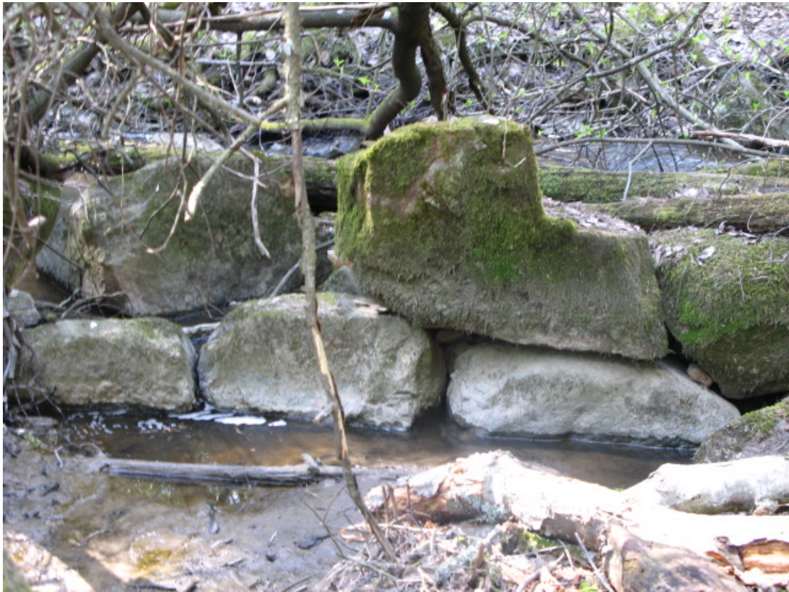
Kuva 41. Yksityiskohta rakenteesta kuvattuna koillisesta. Kuva: Elina Terävä.
