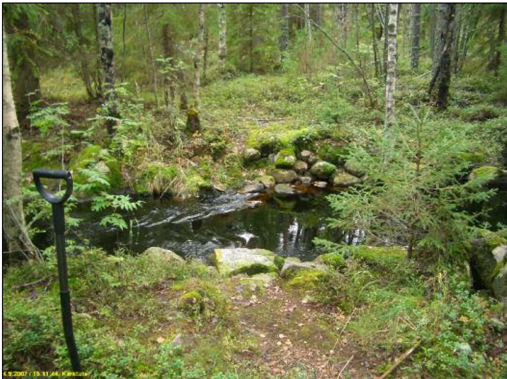
Polkusillan perustuksia jokivarressa.
