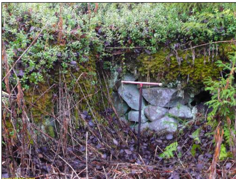
Kuopan kivettyä seinämää.
