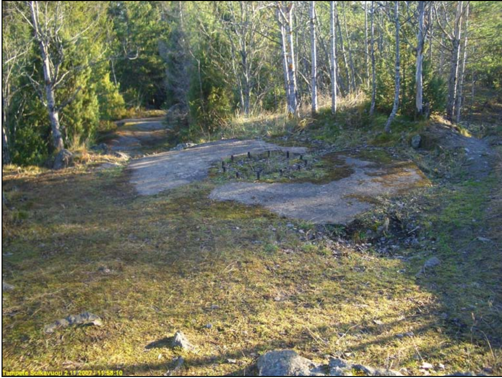
Betoninen tykinperusta. Näitä alueella on seitsemän.
