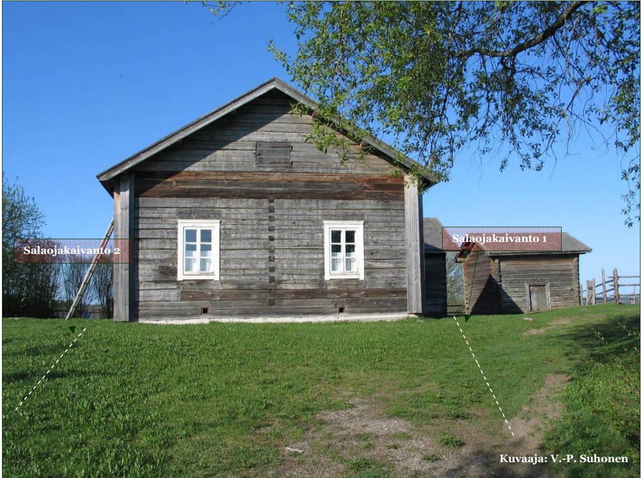
Kuva 3: Salaojakaivantojen paikat ennen kaivutöiden aloittamista.
