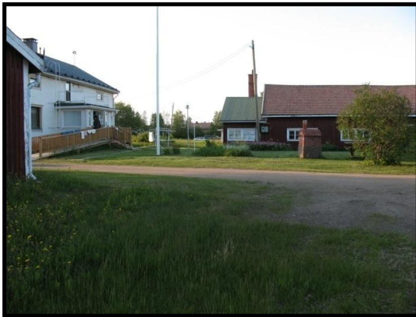
Kuva 12. Mäkituomas 2:n nykyistä rakennuskantaa (36)
