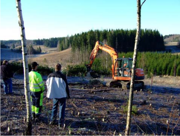
Kuva 1 / DG. 256: 1 Maan koneellinen poisto aloitettiin autotallin rakennuspaikan kohdalta, kuvattu pohjoiskoillisesta.
