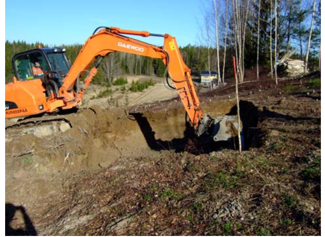
Kuva 2 / DG. 256: 2 Autotallin rakennuspaikan ensimmäinen puolikas kaivettuna pohjaan, kuvattu kaakosta.
