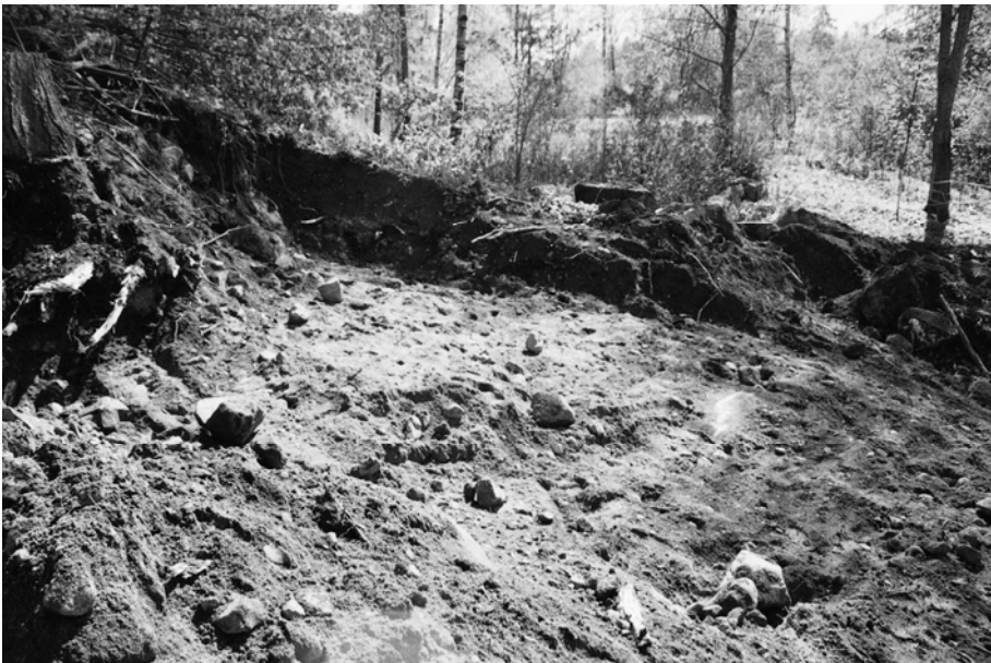
f.145313:2. Kuvassa näkyy koneella kaivettua maata. Kuvattu pohjoisesta.
