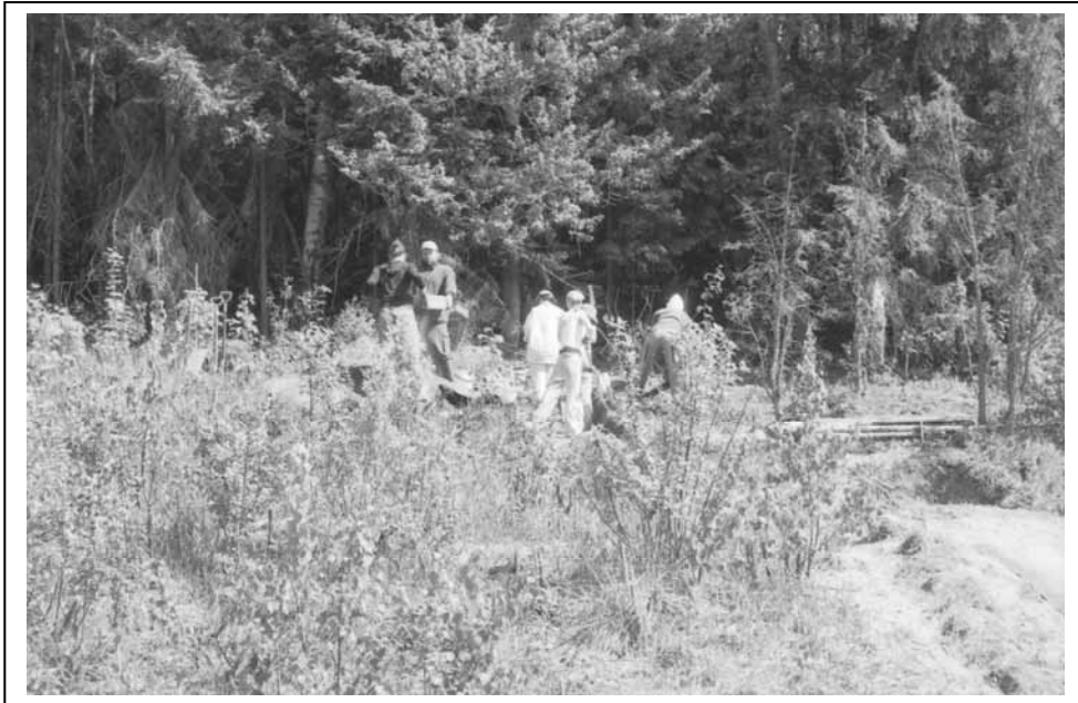
f145719:7 Työkuva. Koeojaa kaivetaan paikalle, jossa hiihtoputken linjaus leikkaa asuinpaikkaa. Lännestä.
