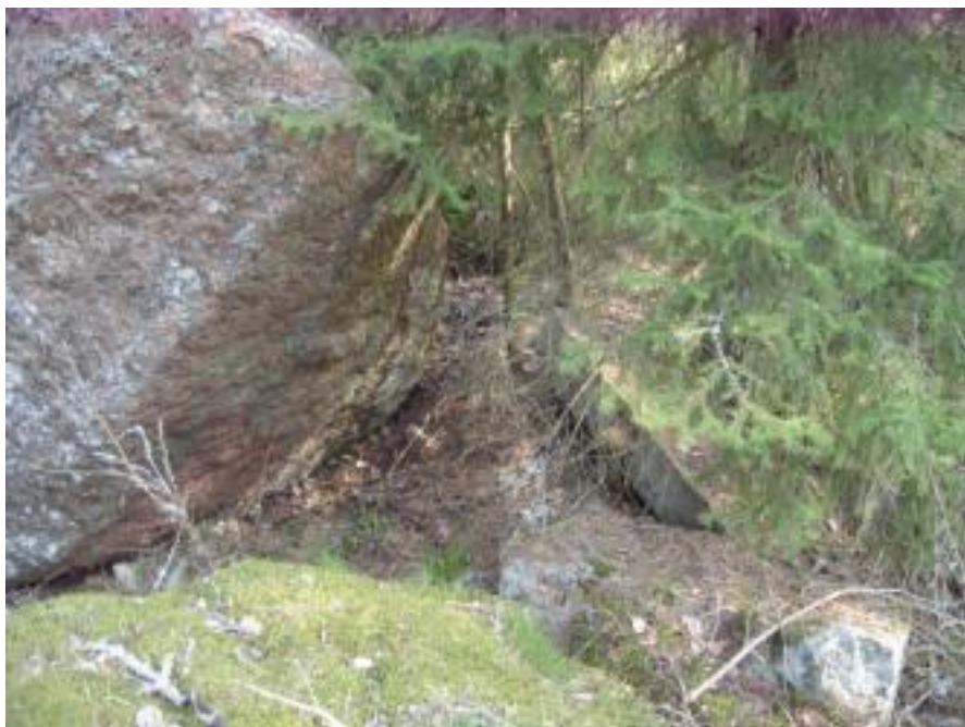
Kivityömiesten majan louhituista laakakivistä ja lohkareista kylmämuurattu seinä on sortunut sisään. Majan sisätila on muodostunut isomman siirtokivilohkareen viiston seinän ja toiselle puolelle kylmämuuratun seinän väliin. Kuva otettu pienemmän siirtokivilohkareen päältä. Kuva Teemu Mökkönen.
