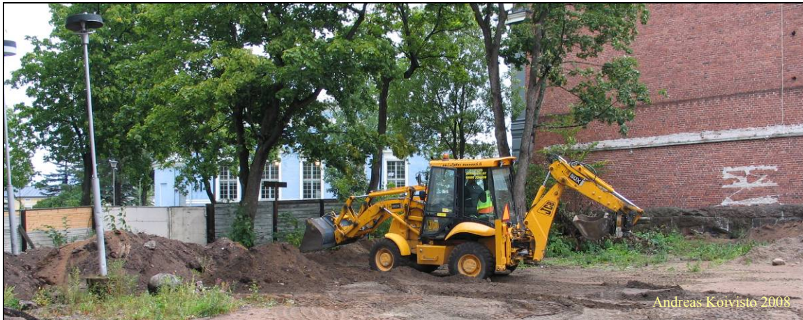
Kuva 4. Kaivauksissa käytettiin apuna konetta.
