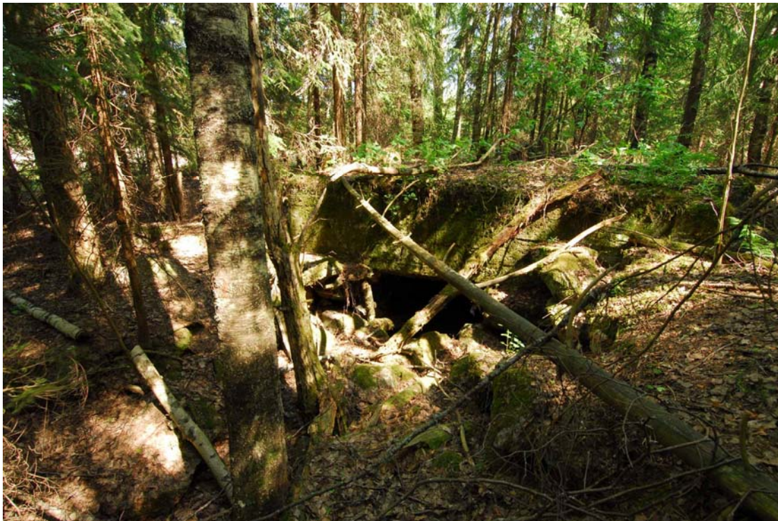
Luumäki, Tahvola. Betonibunkkerin oviaukko kuvattuna lännestä. (DG366:1)
