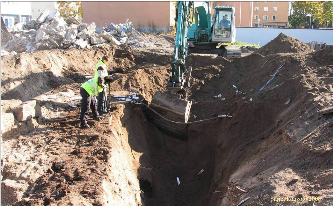
Kuva 2. Maat eskarppimuurin ympäriltä poistettiin koneellisesti.
