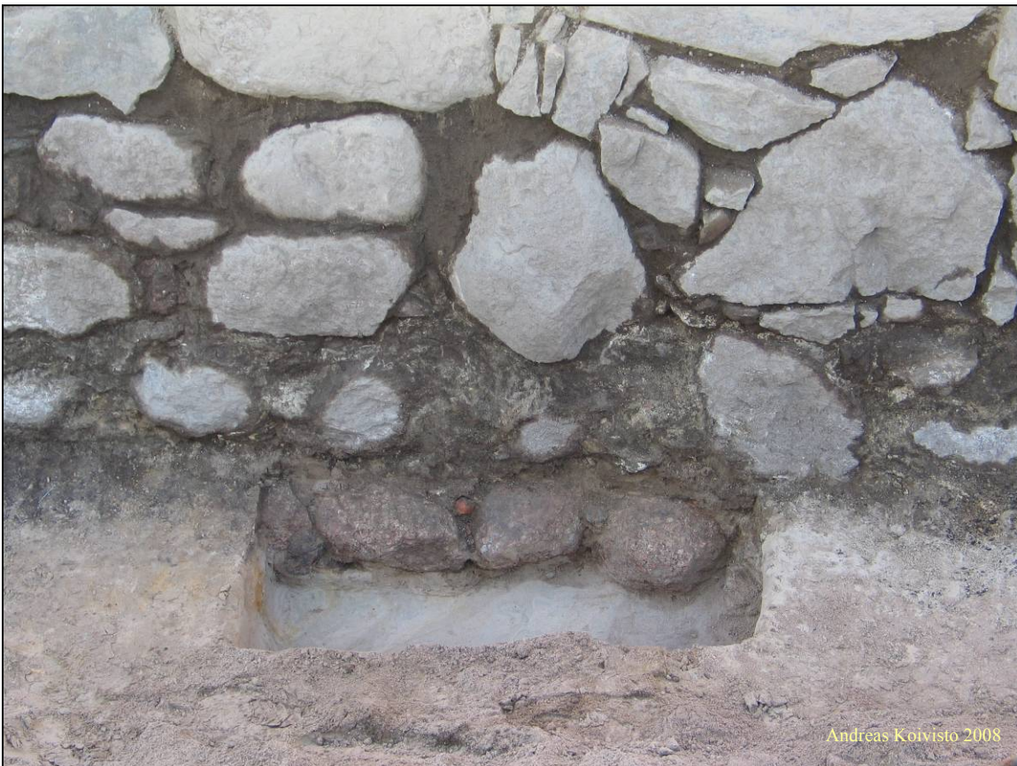
Kuva 5. Eskarppimuurin anturakivet olivat n. 30 cm ulompana kuin muut muurin kivet.
