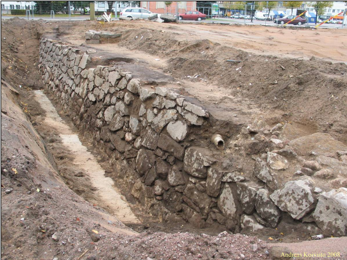
Kuva 3. Bastionin muuri. Taustalla muurin päällä näkyy vielä Aholaisenkulman rakennuksen kiviperustuksia.
