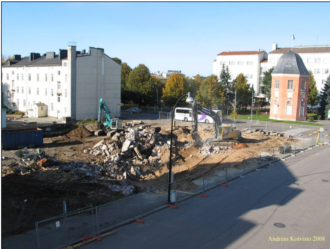
Kuva 1. Tutkimusten alkaessa Aholaisenkulman tontti oli tämän näköinen.
