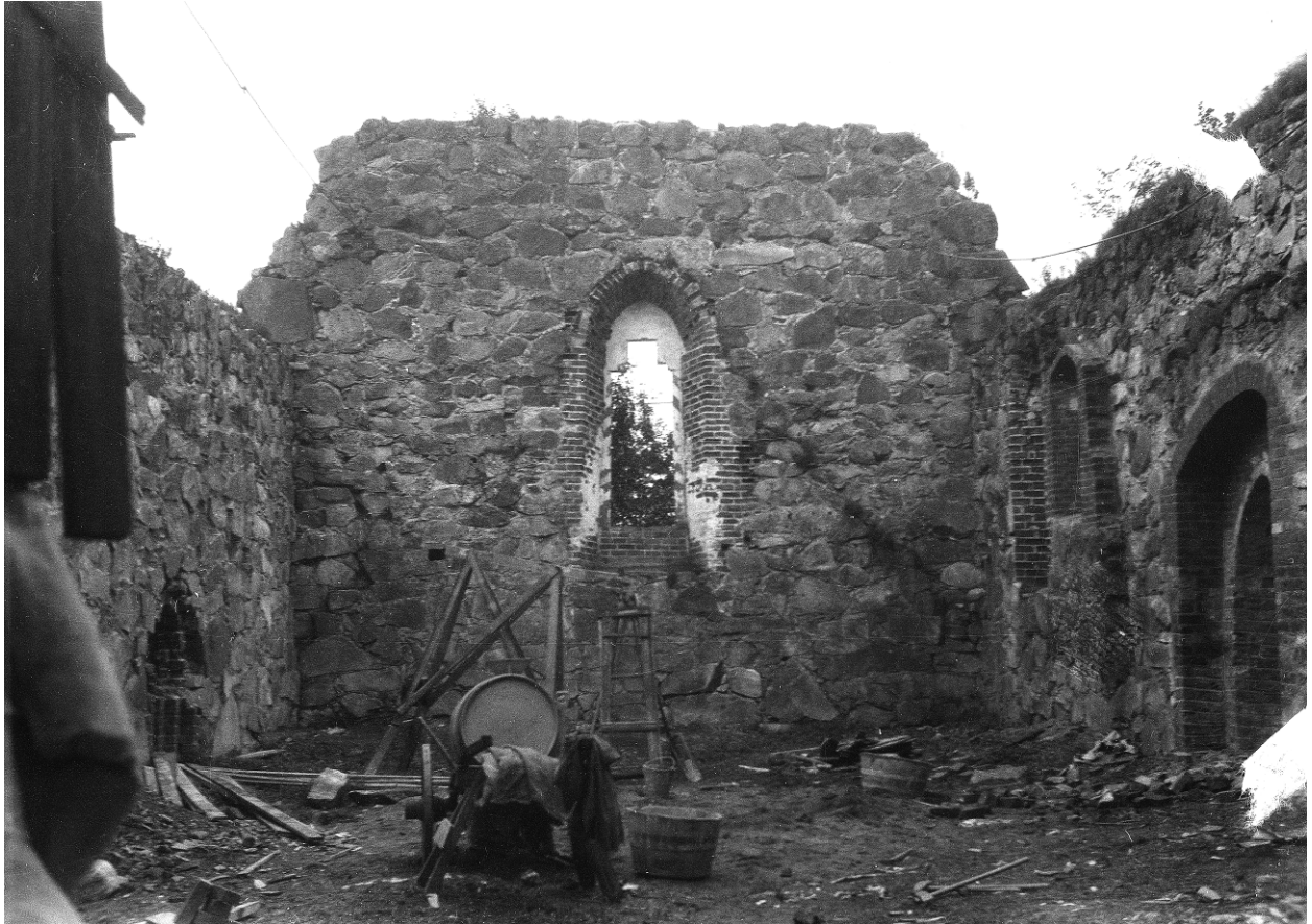
Kuva. Ovien ja ikkunoiden pieliä on jo uusittu ja itäpäädyn halkeama on paikattu. Museovirasto, Historian kuva-arkisto neg 20111.
