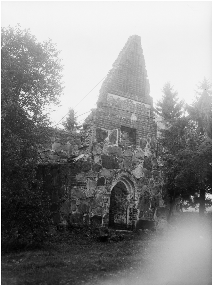
Kuva. Asehuoneen kallistuneeseen päätyyn asennettiin ylimmät sideraudat. Erkki Kivistö, Museovirasto, Historian kuva-arkisto Neg. 45198.
