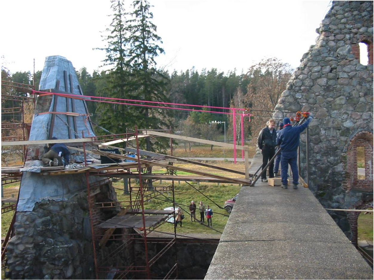
Kuva. Asehuoneen päädyn suoristaminen taljojen ja ketjujen avulla on käynnissä syksyllä 2004. Sanna Ihatsu, Museovirasto.
