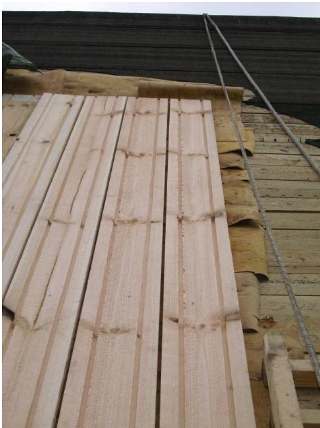
Kuva. Katon rakentaminen on käynnissä kesällä 2007. Virve Suominen.
