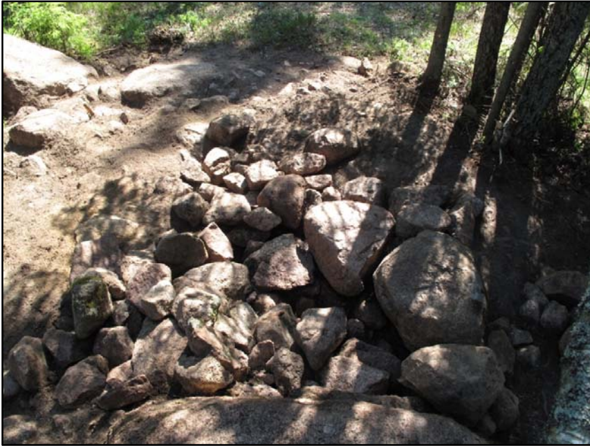
Kuva 1 Kivirakenne pintamaiden poiston jälkeen.
