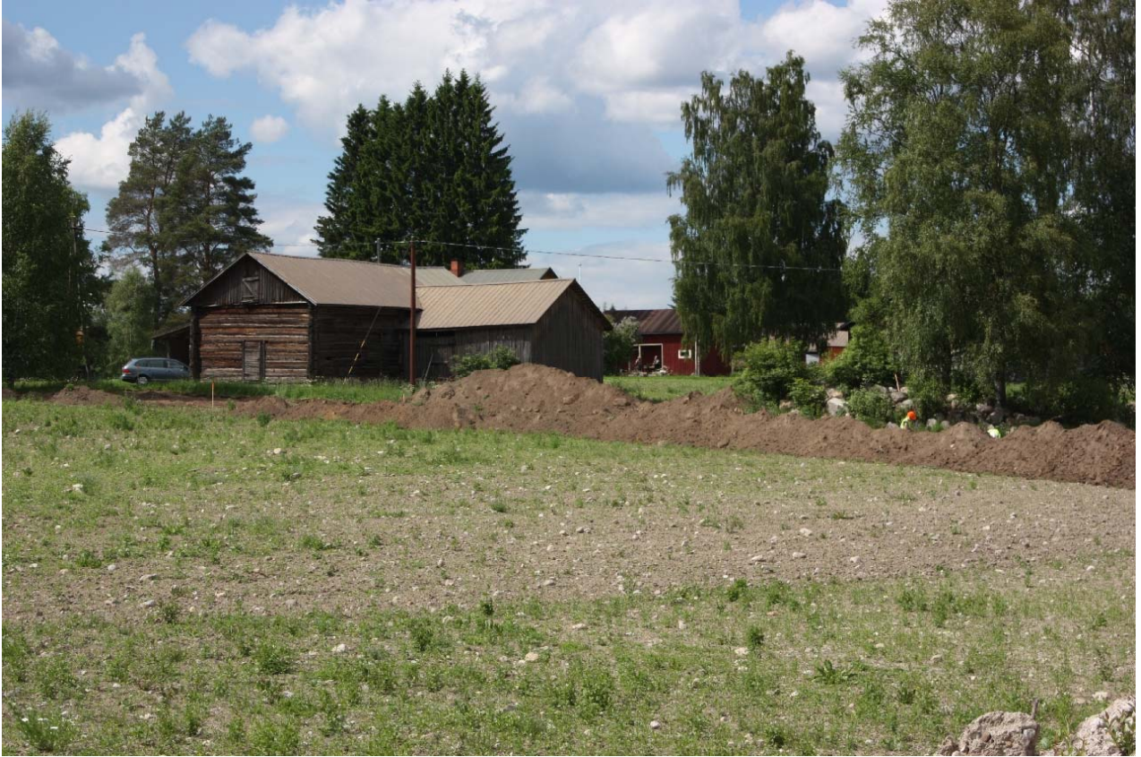
DG 667:6. Tielinjaus kuorittuna, kaakosta. Harjulan lato, jonka edustalta uusi tilustie kulkee. 22.6.2009.
