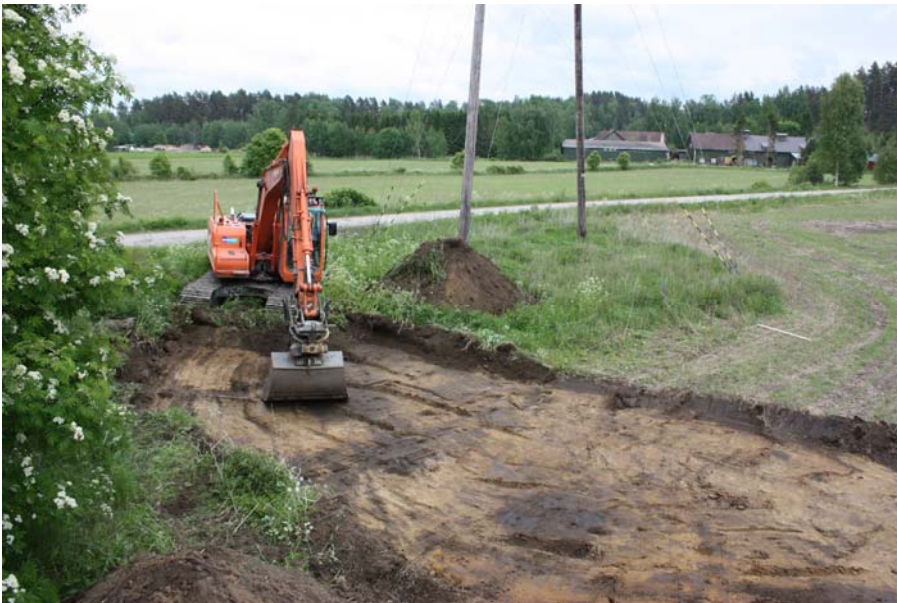
DG 666:10. Valtatien ja Ruskealantien välistä kevyenliikenteenväylän osaa kuoritaan peltomullasta, lännestä. 10.6.2009.
