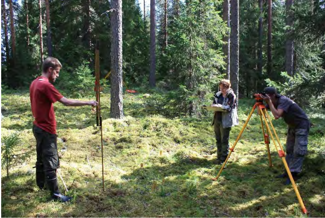
Kuva 5. Työkuva: aluetta 2 vaaitaan. Kuva: Petro Pesonen.
