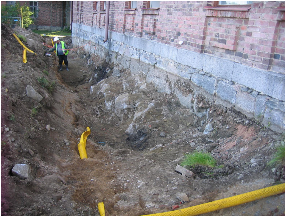
Kuva 7. K3a. Länsisivulla perustusten alla olevaa kalliota.
