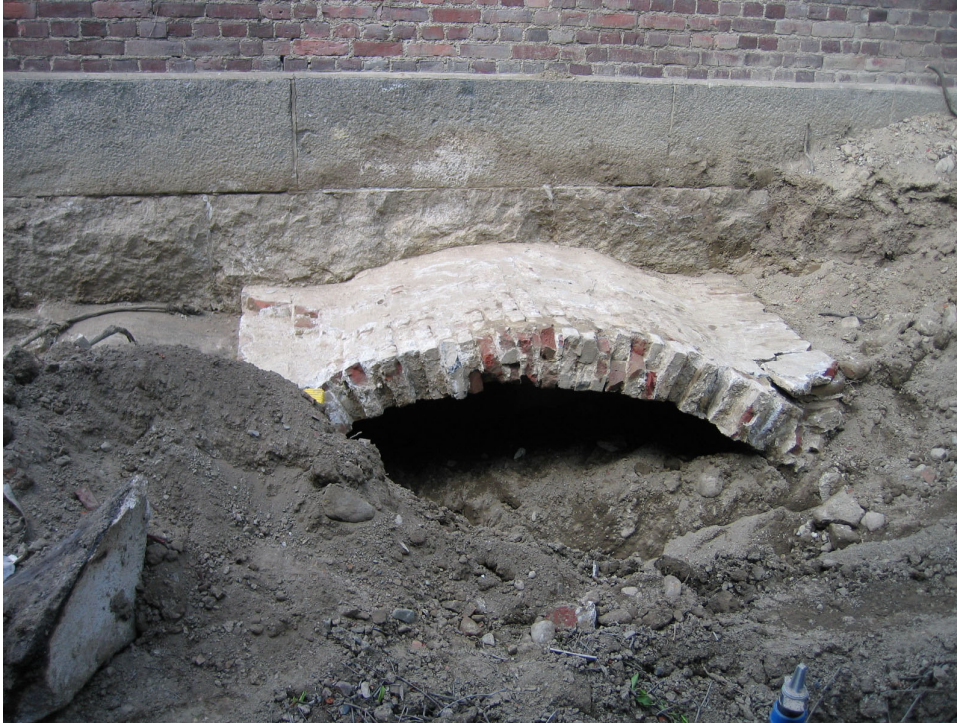
Kuva 4. Kellarin holvi esiin puhdistettuna.
