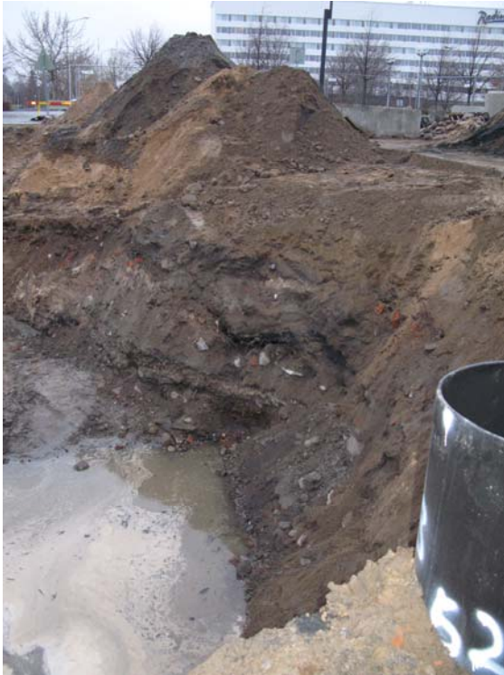
Kuva 1. Yleiskuva kaivannosta. Kuvattu koilliseen.
