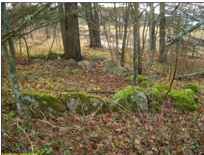
Alarinteessä, pellon liepeillä oleva rakennuksen perusta
