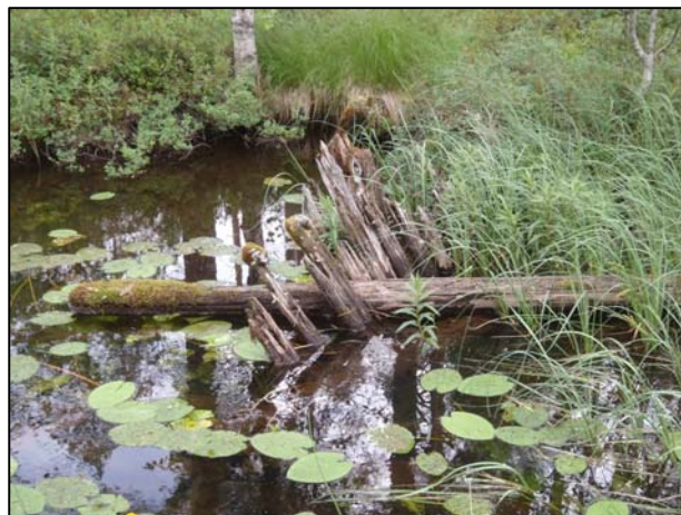
79447 Yleiskuva padon itälaidasta lounaasta
