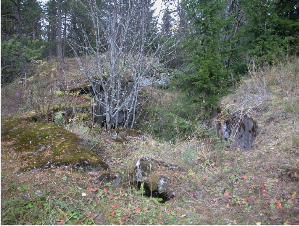
Kuva 6. Urjalan Huhdin linnoitusalueella Visan talon lounaispuoleisella mäellä sijaitseva betoninen konekivääriasema. 13.10.2008, Hanna-Leena Salminen PMM/KYY digitaalinen kuva 49
