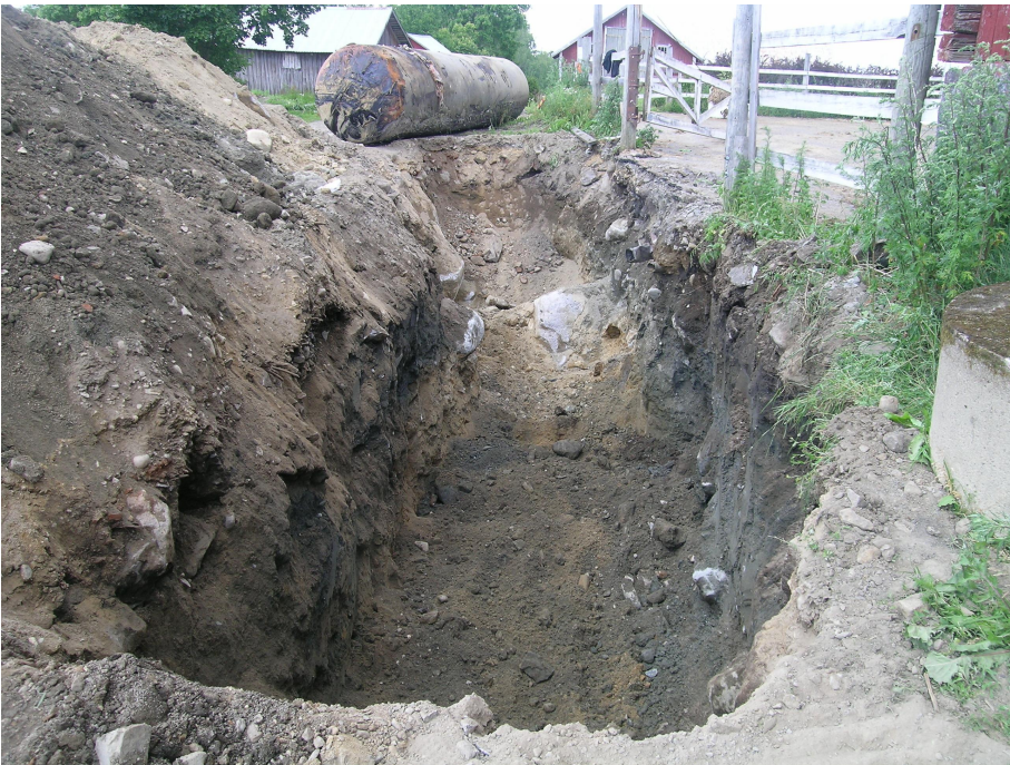
Kuva 4. Kaivanto valmiina, syvyys n. 2,5 m maanpinnasta. Kuva Aija Teinonen.
