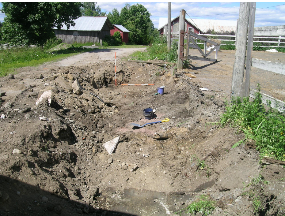
Kuva 2. Kaakosta kuvattu kaivantoa ensimmäisen kaivuukerroksen jälkeen. Kuva Aija Teinonen.
