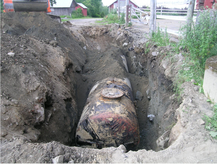
Kuva 5. Säiliö sijoitettuna kaivantoon. Kuva Aija Teinonen.
