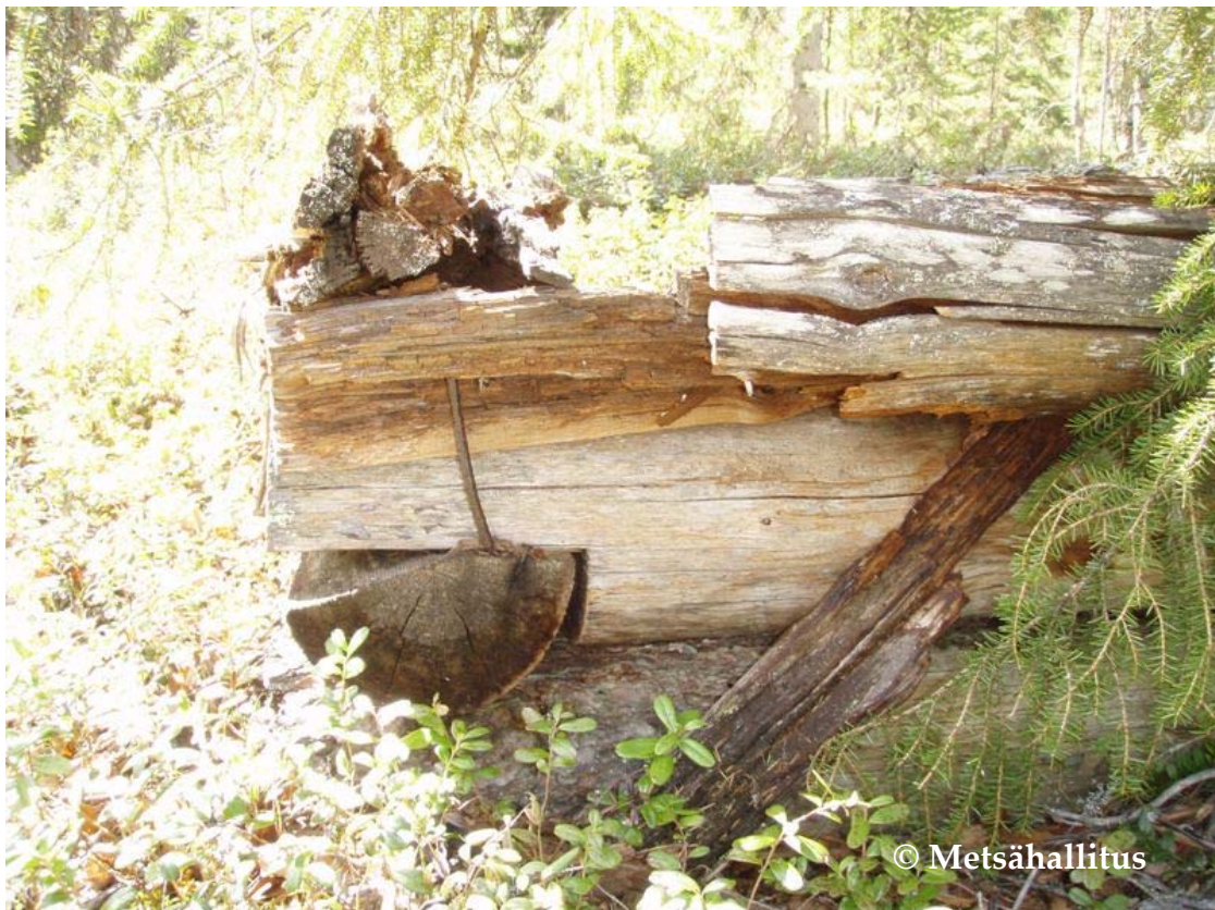
Kuva 22. Auttijoki 43. Hirsirakennuksen kulma.
