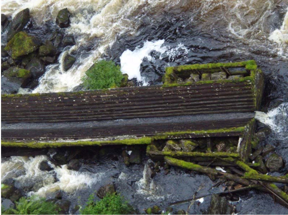
Kuva 20. Auttiköngäs 7. Uittoruuhien alaosa ja sen alapuolinen lahonnut arkku. Kuvattu idästä ylhäältä kurun reunalta.
