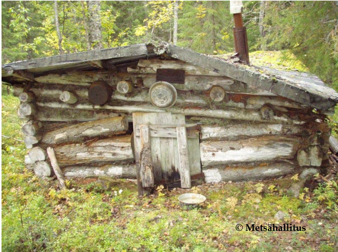
Kuva 17. Vaajoki 2. Kämpän julkisivu.
