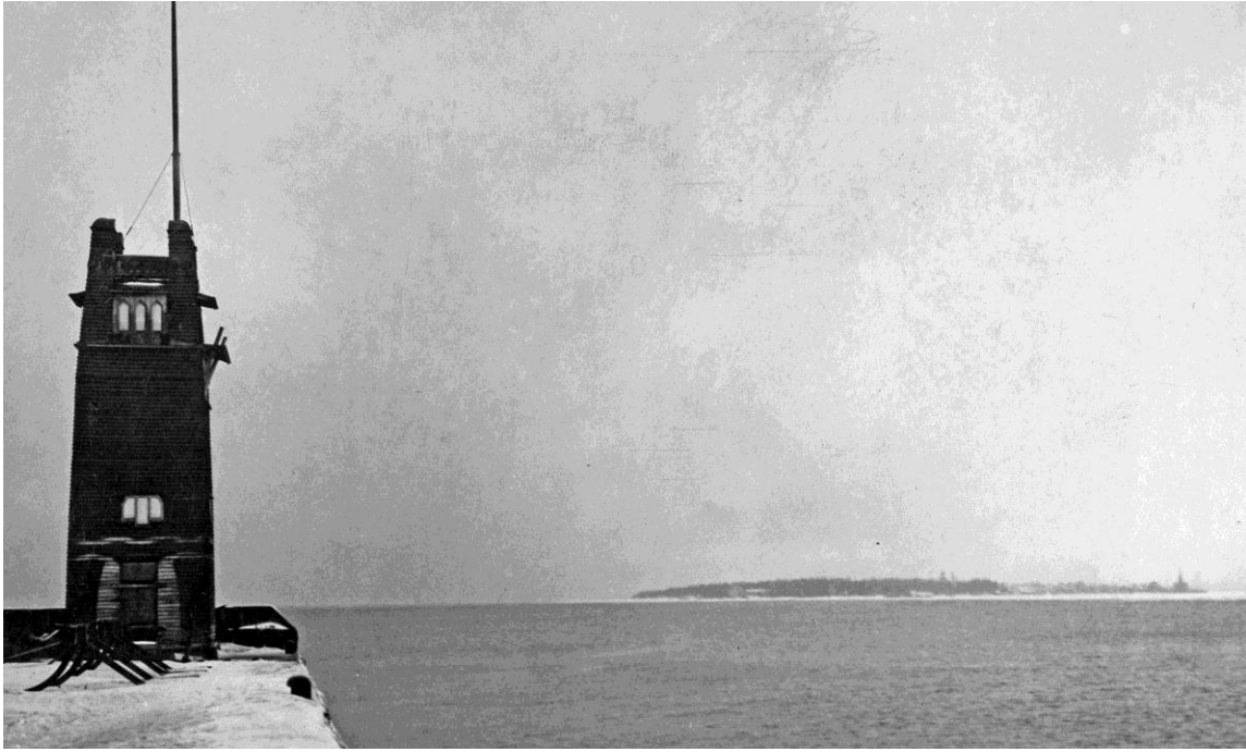
Kuva 4. Mäntyluodon sataman kivilaiturin päässä sijaitseva ”Ryssäntorni”. Taustalla Reposaaari. Satakunnan museon kuva-arkisto.
