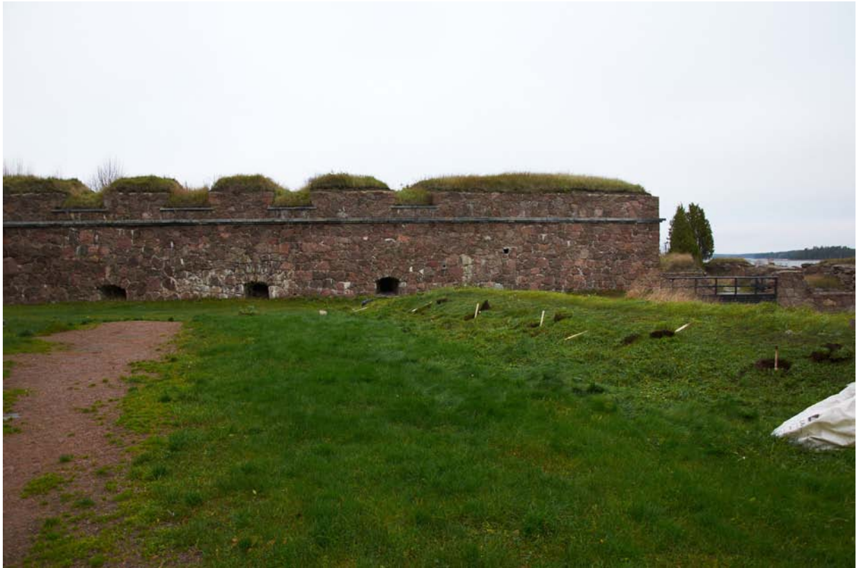
Kuva 1. Linnoituksen itäisen rantavallin turva-aidan perustuskuoppia kaivettuna. Rantavallin vieressä sijaitsee Svartholman kesäravintola, ja vallia on korotettu puutarhamaalla jo aiemmin turvallisuuden parantamiseksi. Taustalla näkyy bastioni Qveckfeltin muuri. DG2257:12.
