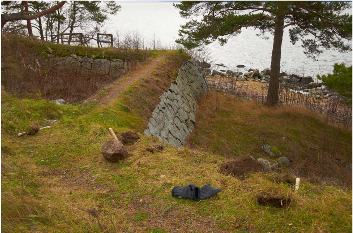
Kuva 3. Läntisen rantavarustuksen päälle rakennettavan turva-aidan perustuskuoppia. Päädyssä muurikivi tuli vastaan jo 10 cm syvyydessä. DG2257:33.
