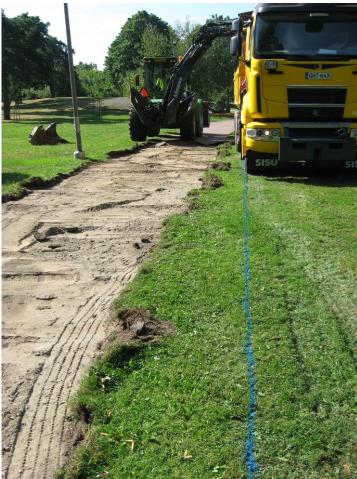
Kuva 4: Saneeraustyöt alkuvaiheessa. Käytävä 1:n asfaltti on poistettu ja käytävää on ryhdytty leventämään länsisivulta. N. Kuva: KyM/M. Kykyri.
