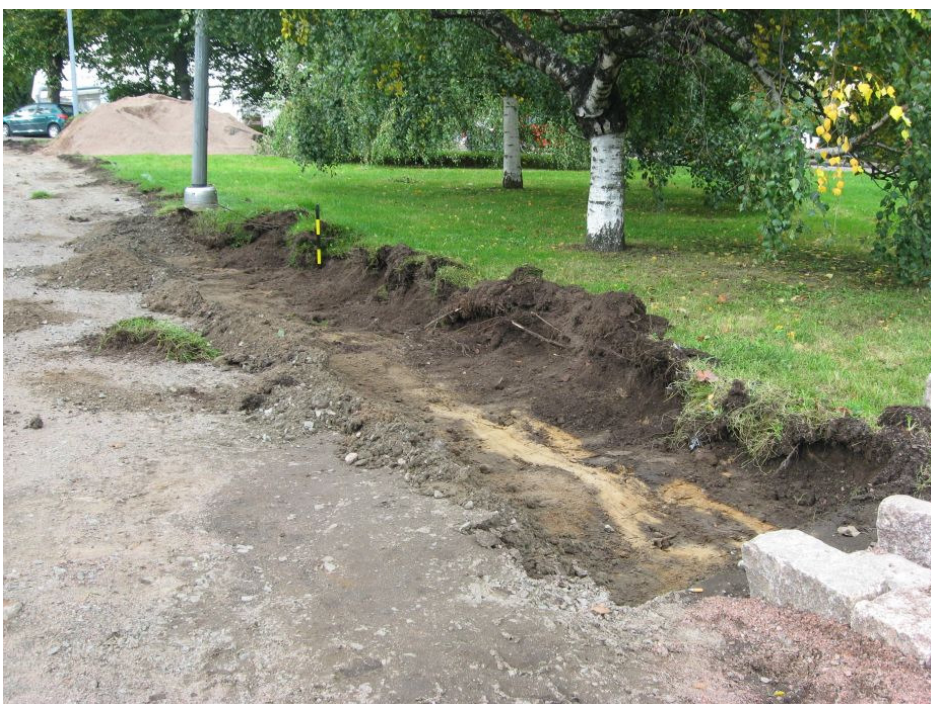
Kuva 25: Käytävän N-seinämaa esiin kaivettuna. Multakerrosten ja asfaltin pohjustushiesun alla näkyy rautaoksidipitoisen kellertävän hiesukerroksen pintaa. Mittatikku on maapilari MP 24:än kohdalla. Oikealla alakulmassa on esillä valmiiksi asennettua nupukivistä vesiuraa. NE. KyM/M. Kykyri.
