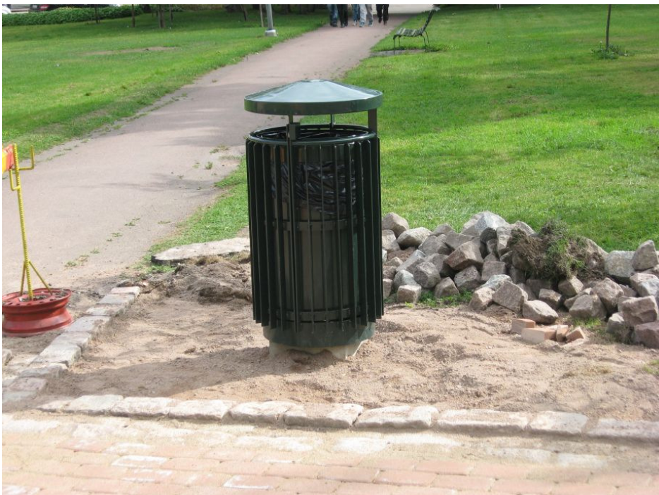
Kuva 16: Roskakorin K 503 paikka ennen noppakivikatteen asentamista. W. KyM/M. Kykyri.
