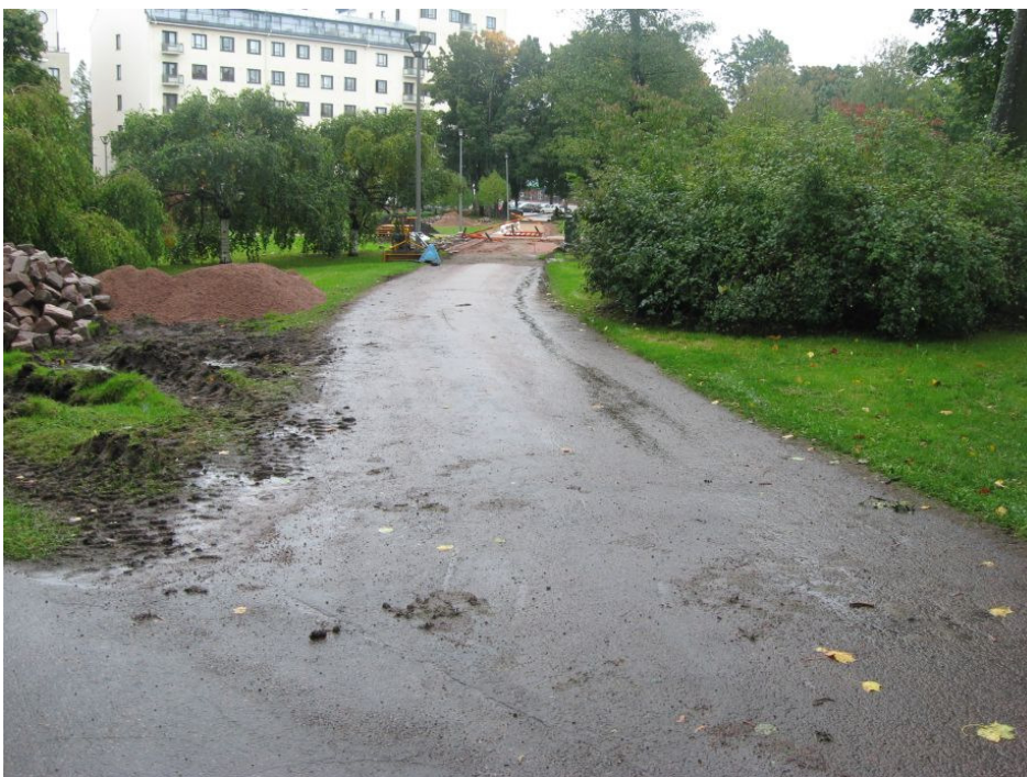
Kuva 24: Käytävä 4 ennen saneerausta ja asfaltin poistoa. W. KyM/M. Kykyri.
