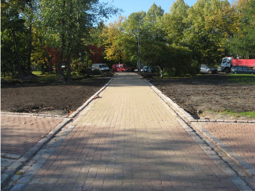
Kuva 26: Käytävä 4 saneerattuna. Käytävän molemmin puolin näkyy alueelle syksyllä 2010 levitetty uusi kompostimultakerros. E. KyM/M. Kykyri.
