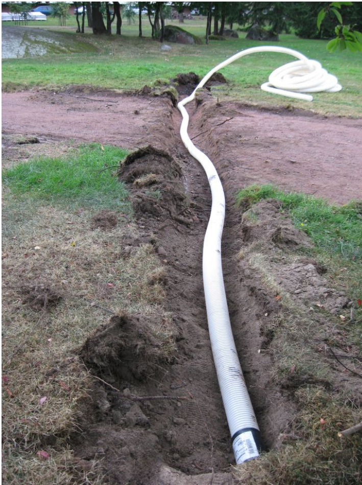
Kuva 17: Salaoja 1 pohjaan kaivettuna. Peruskallion pinta tuli vastaan jo kuvassa näkyvällä syvyydellä kaivannon NE-päässä (kuvan alareuna) sekä puisto-käytävän keskiosassa. NE. KyM/M. Kykyri.
