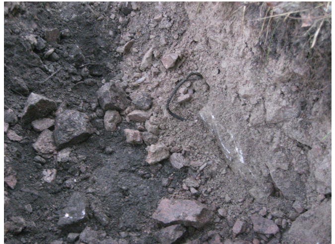
Kaivannon seinämässä noin metrin syvyydessä oli uusi vajjeri.
