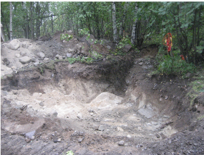
Käänstöpaikan koillisreunaan kaivettu alue ja siihen liittyvä koeoja.
