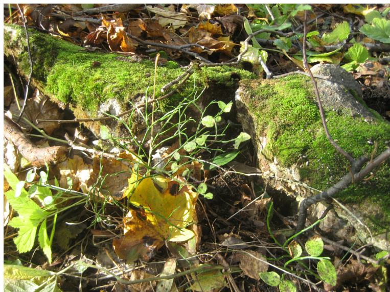
Aidan perustuksen kohdalla oleva betonivalu, jossa erottuu metallipyövään painama pyöreä jälki (kuvan keskellä).
