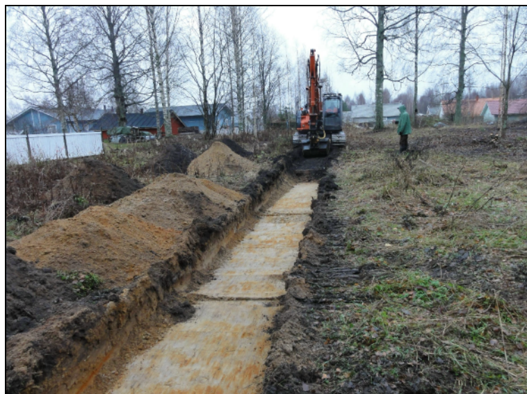
Itäisimmän koeojan kaivuuta sen pohjoispäästä. Kuvattu etelään. ”Puhdasta” maata, luontainen podsolmaannos..
