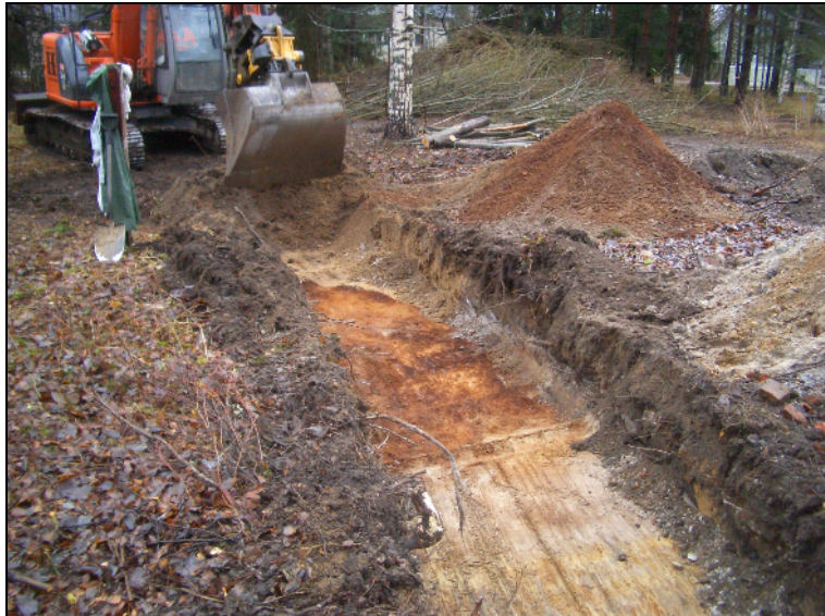
Rakenne 18 pinnassa – vanha täytetty kaivo.
