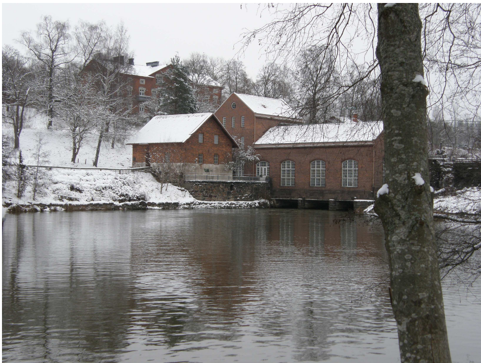
Kuva 6. Kuvassa vasemmalla sähkövoimalaitos ja sen oikealla puolella mylly. Myllyn alapuolella on kivrakenne, jonka päällä vesikanava on kulkenut. Myllyn vasemmalla puolella on sijainnut kankivasarapaja, jonka rakenteet ovat peittyneet nuoremman rakentamisen alle.
