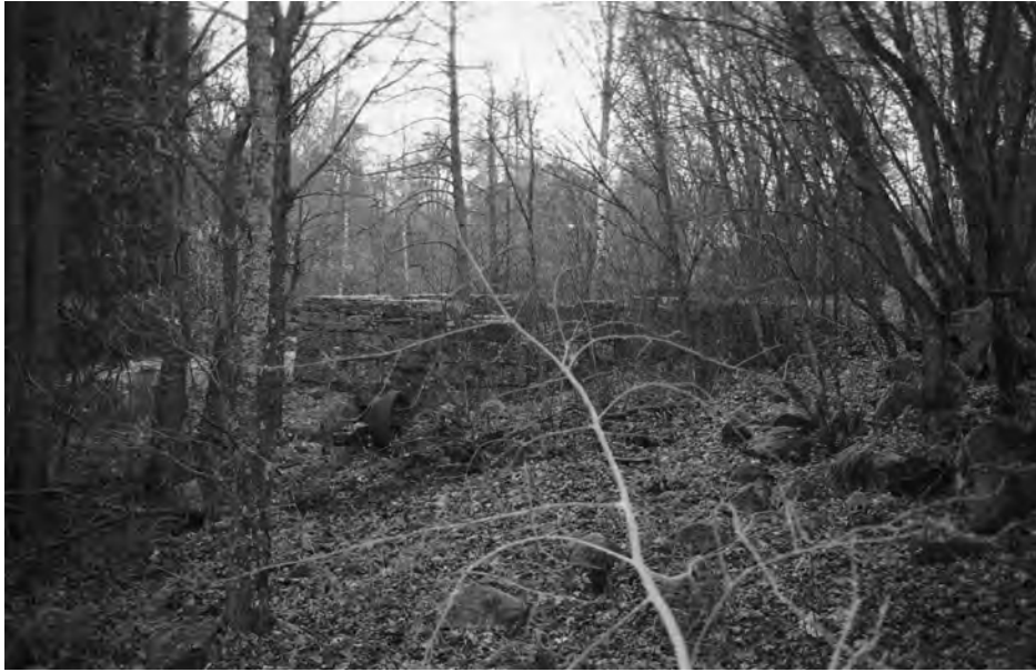
Kuva 7 (mv-kuva 145190:3). Myllyn perustukset ja niihin liittyvät väkipyörän jäännökset. Kuva kaakosta.
