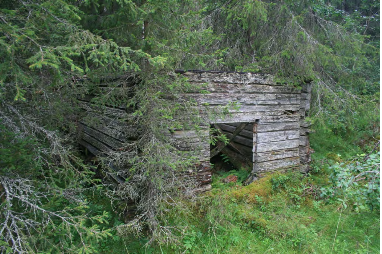
Kuva 23. Uusi kohde 6. Noiviojoki. Osittain sortunut myllyrakennus Noiviojoen pohjoispuolella. Säilyneitä hirsikertoja kaksitoista. Kuvattu itäkoillisesta.
