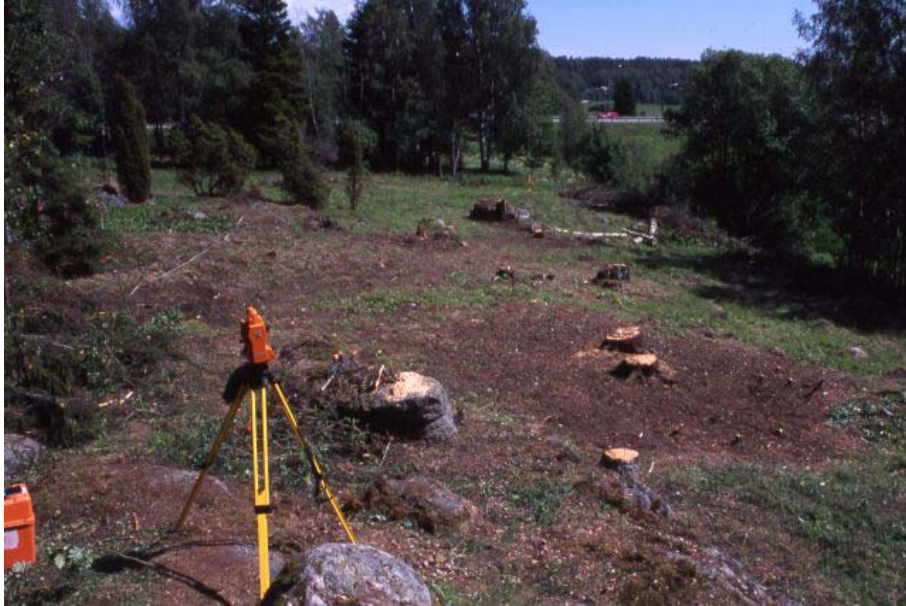
Kuva 1: Kaivausalueet GB1-3 kasvillisuuden raivauksen jälkeen. Kuvaaja: V.-P. Suhonen
