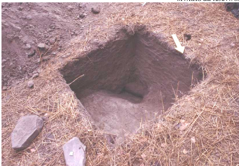
Kuva 18: Koekuoppa I:n pohjalta paljastunut kaapeli.
