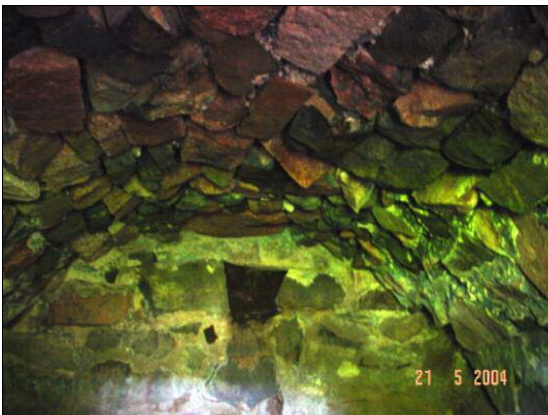
Sisäkuva vanhemman kellarin holvauksesta
