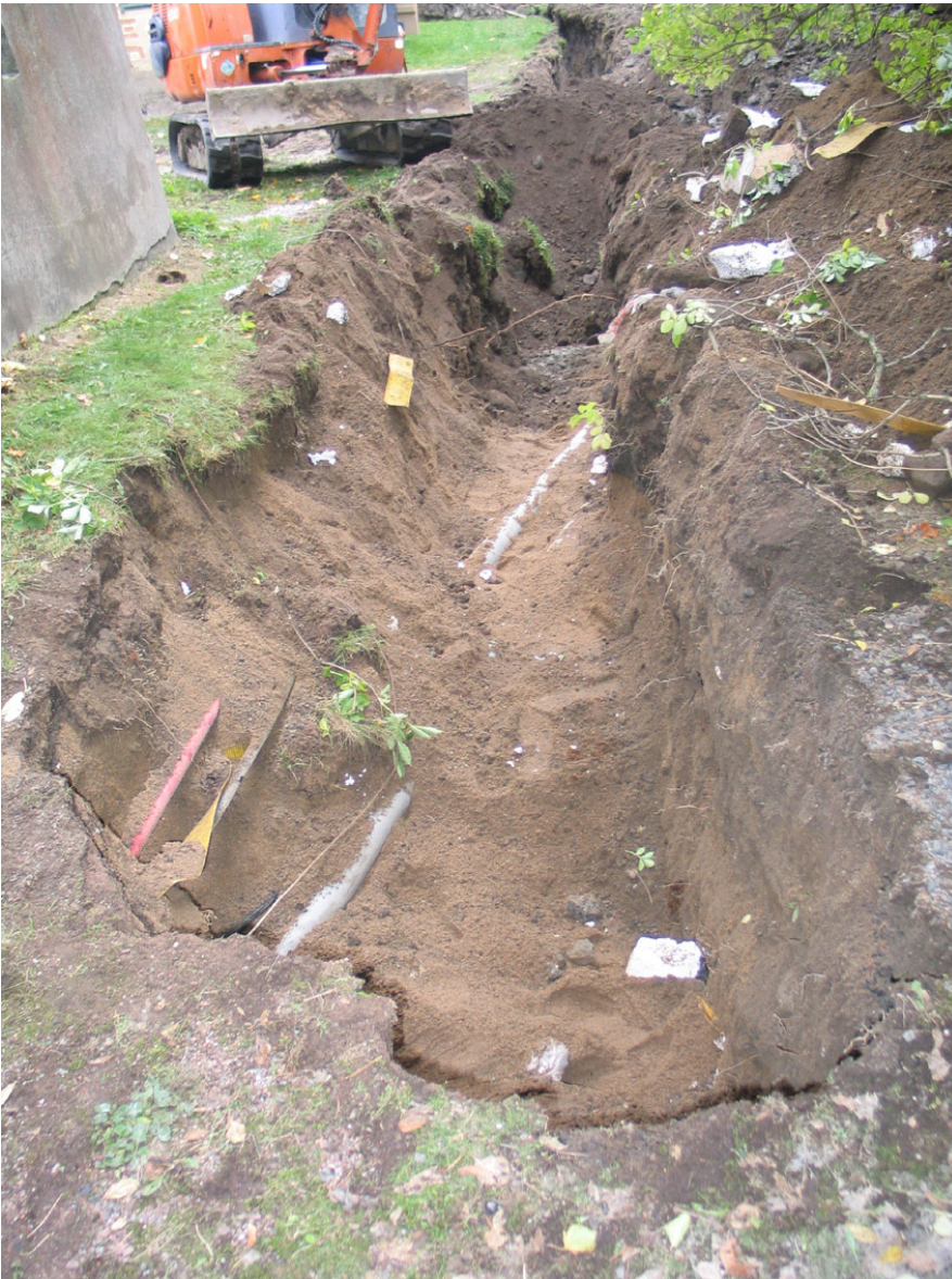
Kaivannon pohjoisosaa Kavaljeerisiiven kellarin oven edustalla
