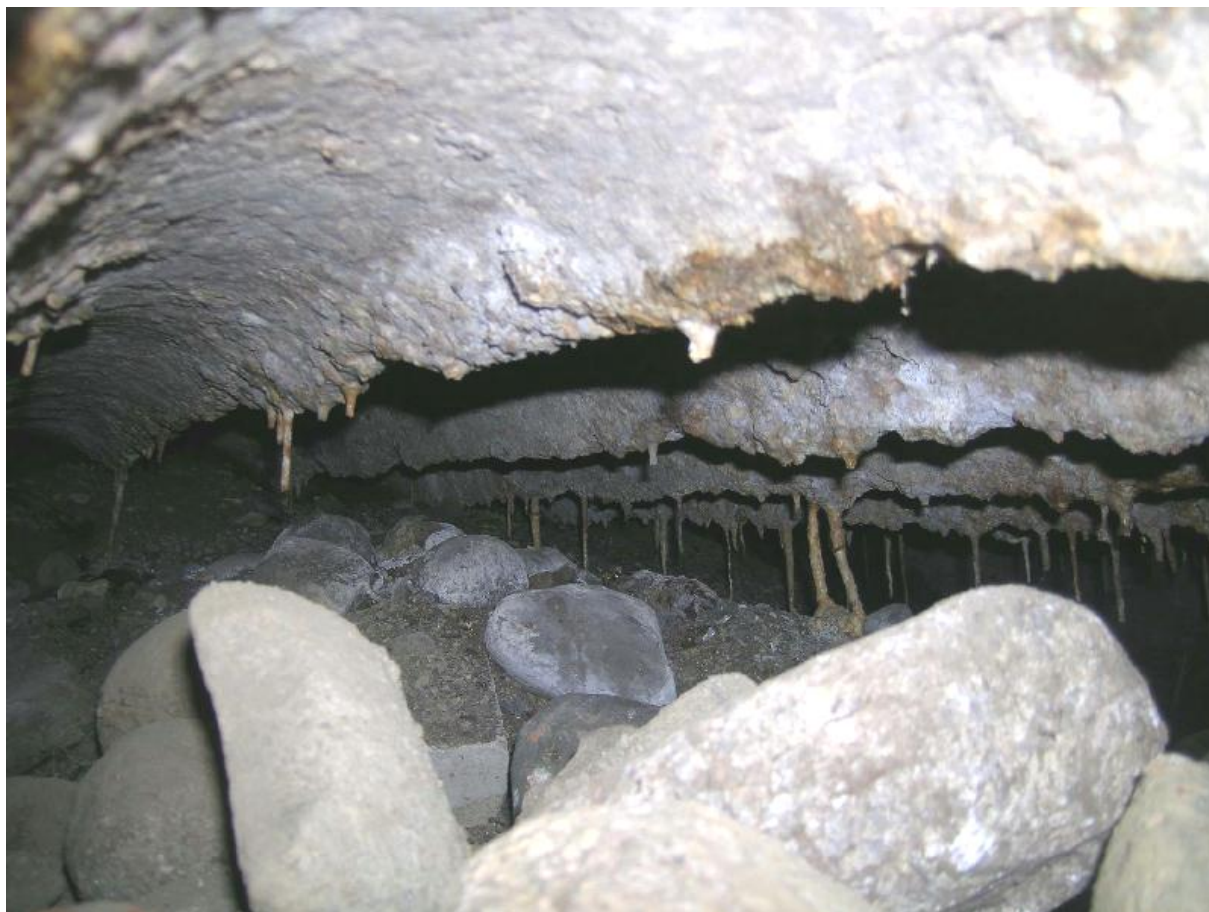
DSCN0387.JPG Pispalanharju, Pispalanharju 34. Betonirakenteen sisätilaa. 14.5.1008, Vadim Adel.
