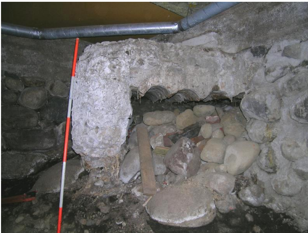
DSCN0386.JPG Pispalanharju, Pispalanharju 34. Betonirakenne. Itäkoillisesta. 14.5.1008, Vadim Adel.
