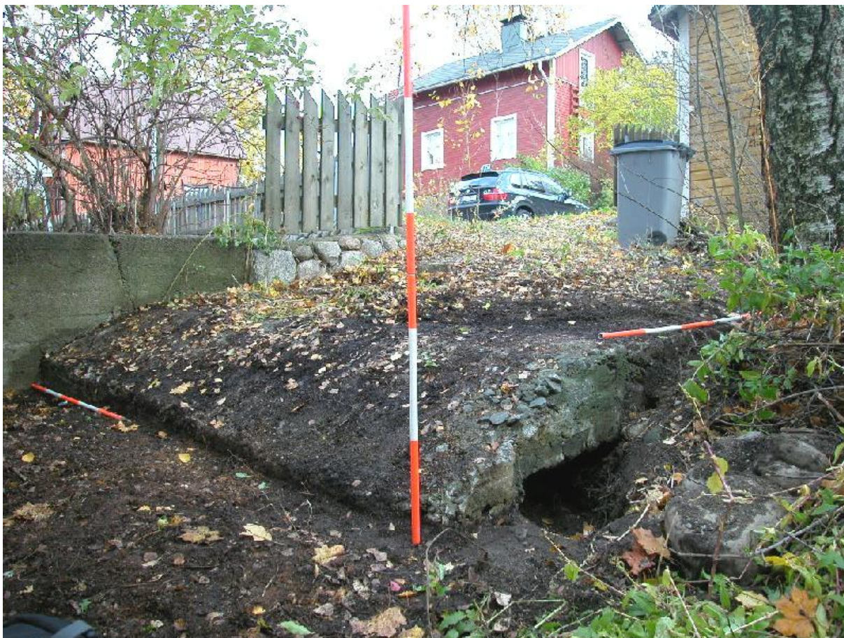
DSCN0012.JPG Betonirakenne. WSW, 6.10.2008, Vadim Adel.
