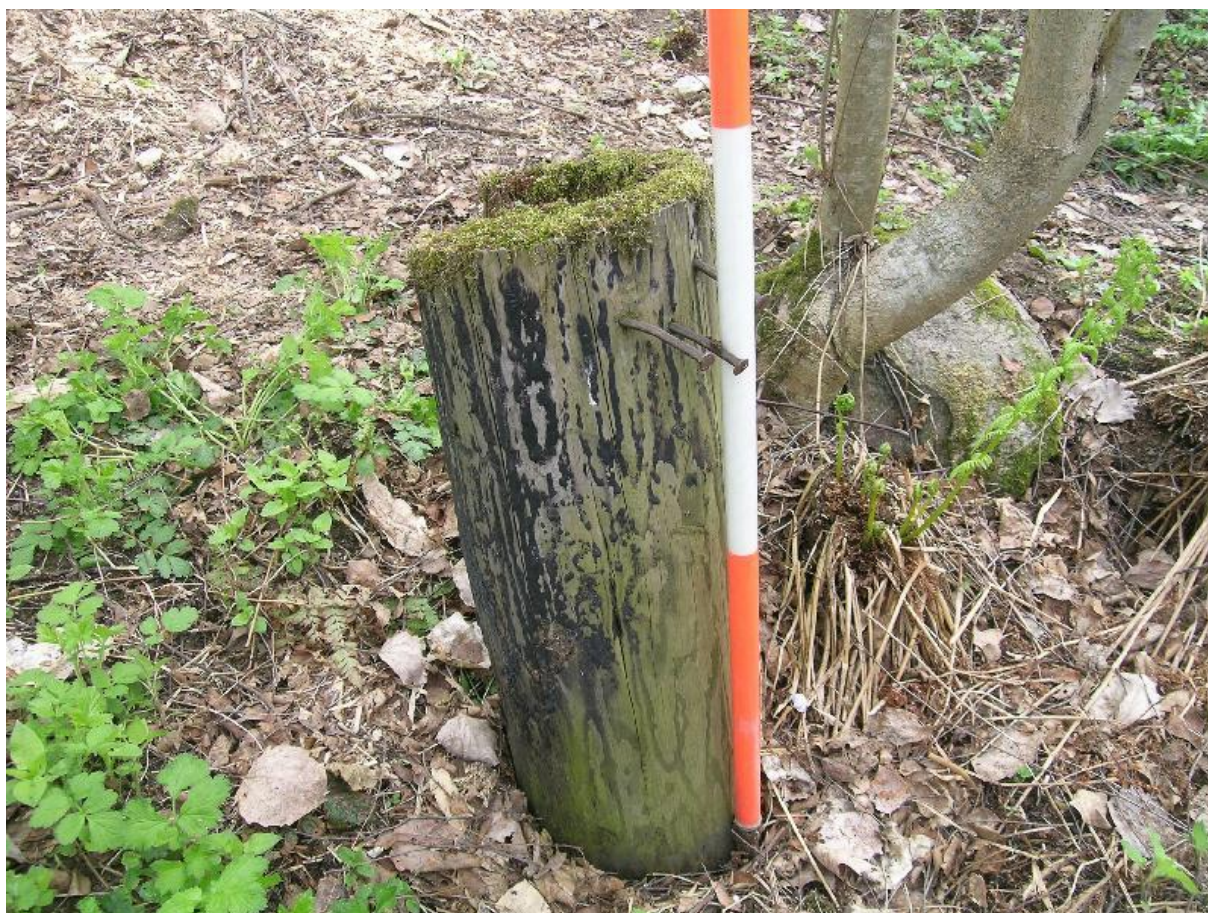
DSCN0297.JPG Pispalan tukkitie 2, puurakenne. 7.5.2008, Vadim Adel.
