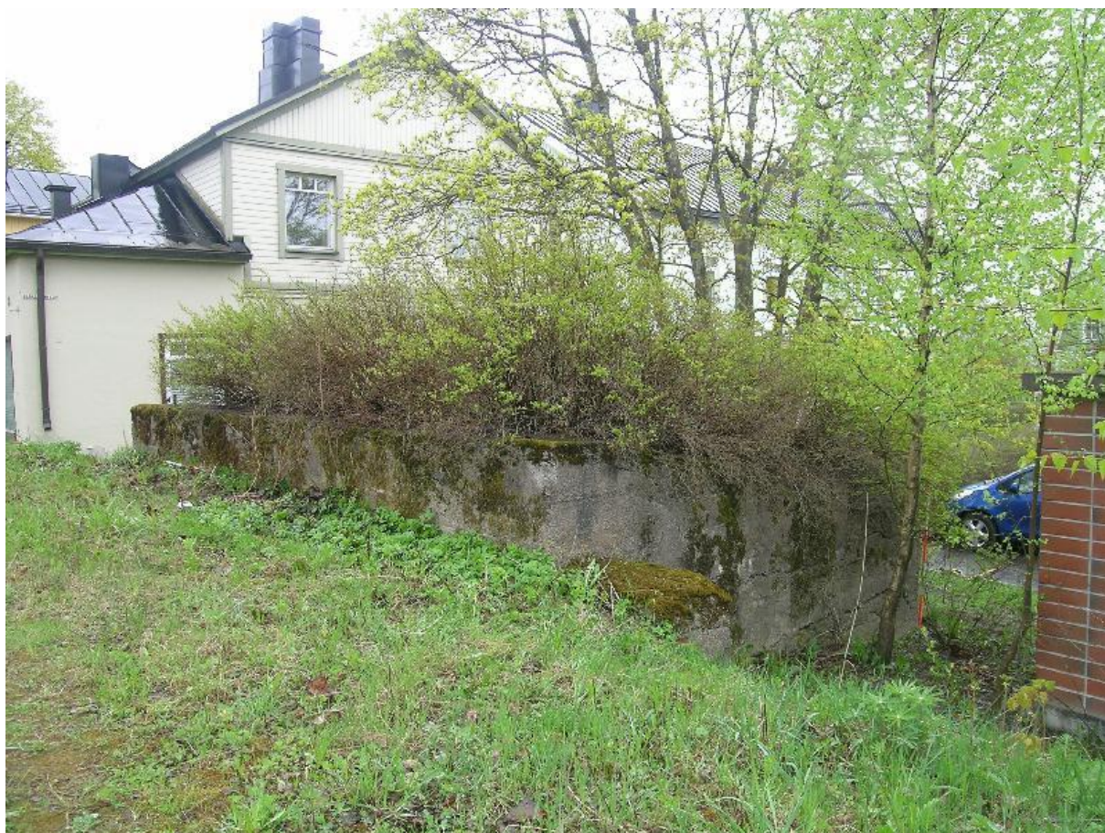
DSCN0305.JPG Pispalan tukkitie 1, betonirakenne. Luoteesta. 7.5.2008, Vadim Adel.
