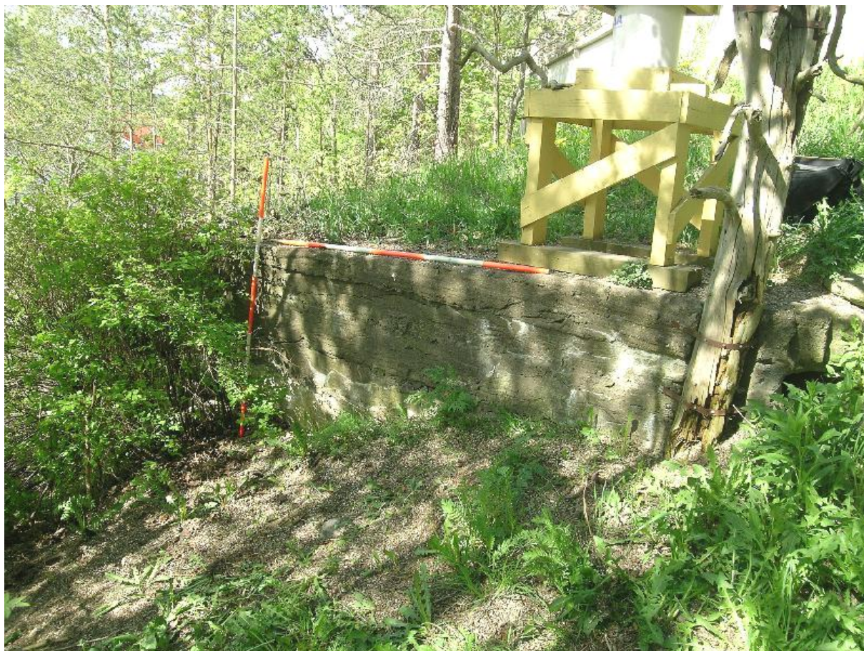
DSCN0354.JPG Pispán koulu. Rakenne 1. Kaakosta. 12.5.2008, Vadim Adel.
