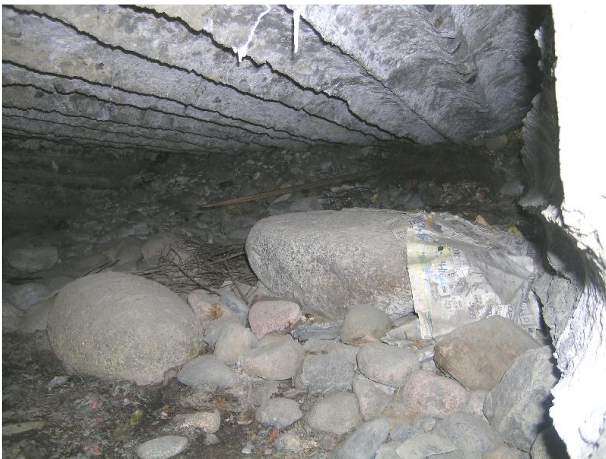
DSCN0348.JPG Pispán koulu. Rakenne 1:n sisätilaa. 12.5.2008, Vadim Adel.
