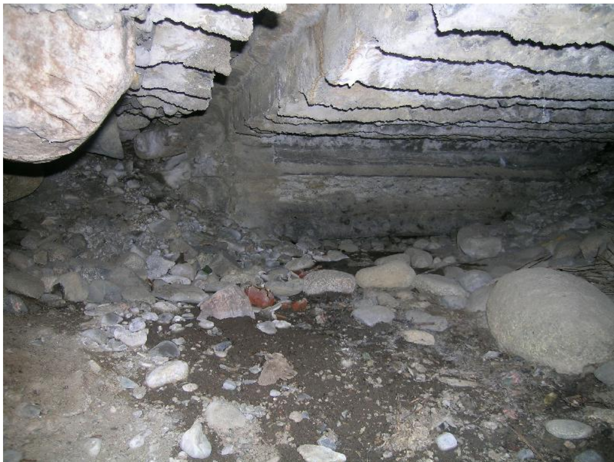
DSCN0349.JPG Pispán koulu. Rakenne 1:n sisätilaa. 12.5.2008, Vadim Adel.
