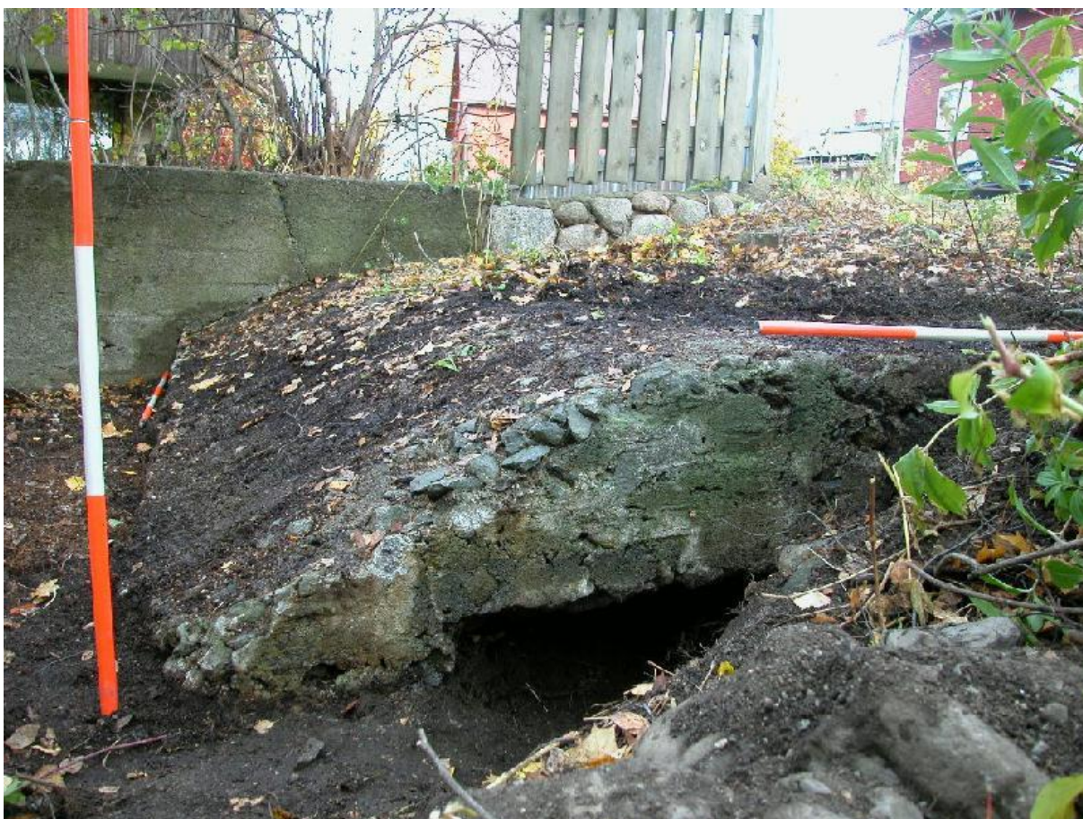
DSCN0015.JPG Betonirakenteen SW-sivua (NW-osa). SW, 6.10.2008, Vadim Adel.
