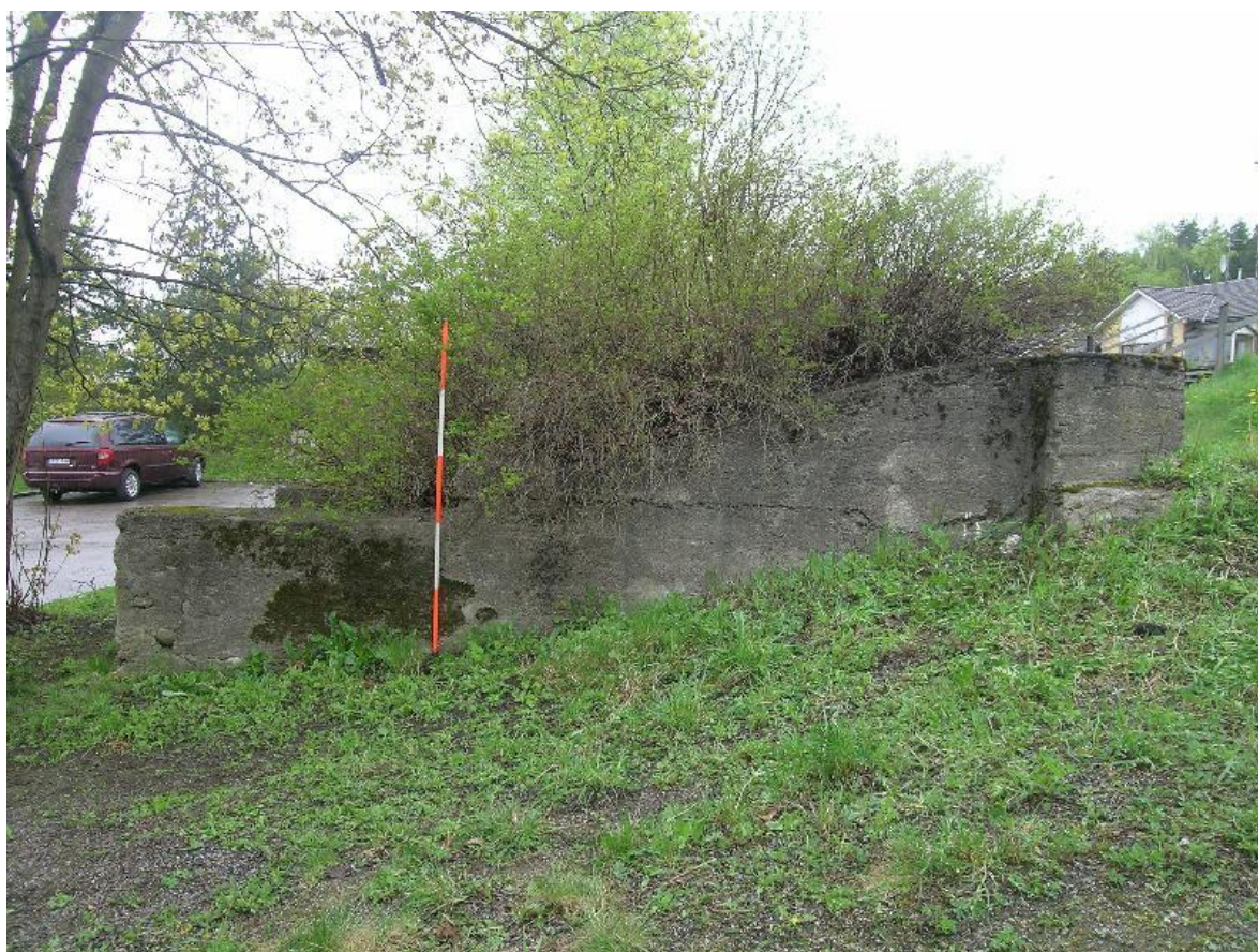
DSCN0302.JPG Pispalan tukkitie 1, betonirakenne. Idästä. 7.5.2008, Vadim Adel.
