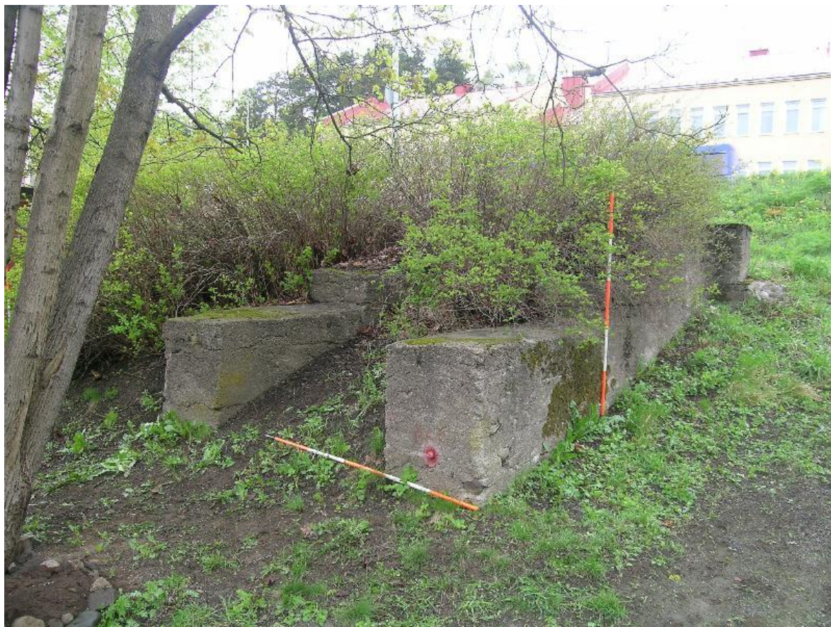
DSCN0301.JPG Pispalan tukkitie 1, betonirakenne. Kaakosta. 7.5.2008, Vadim Adel.
