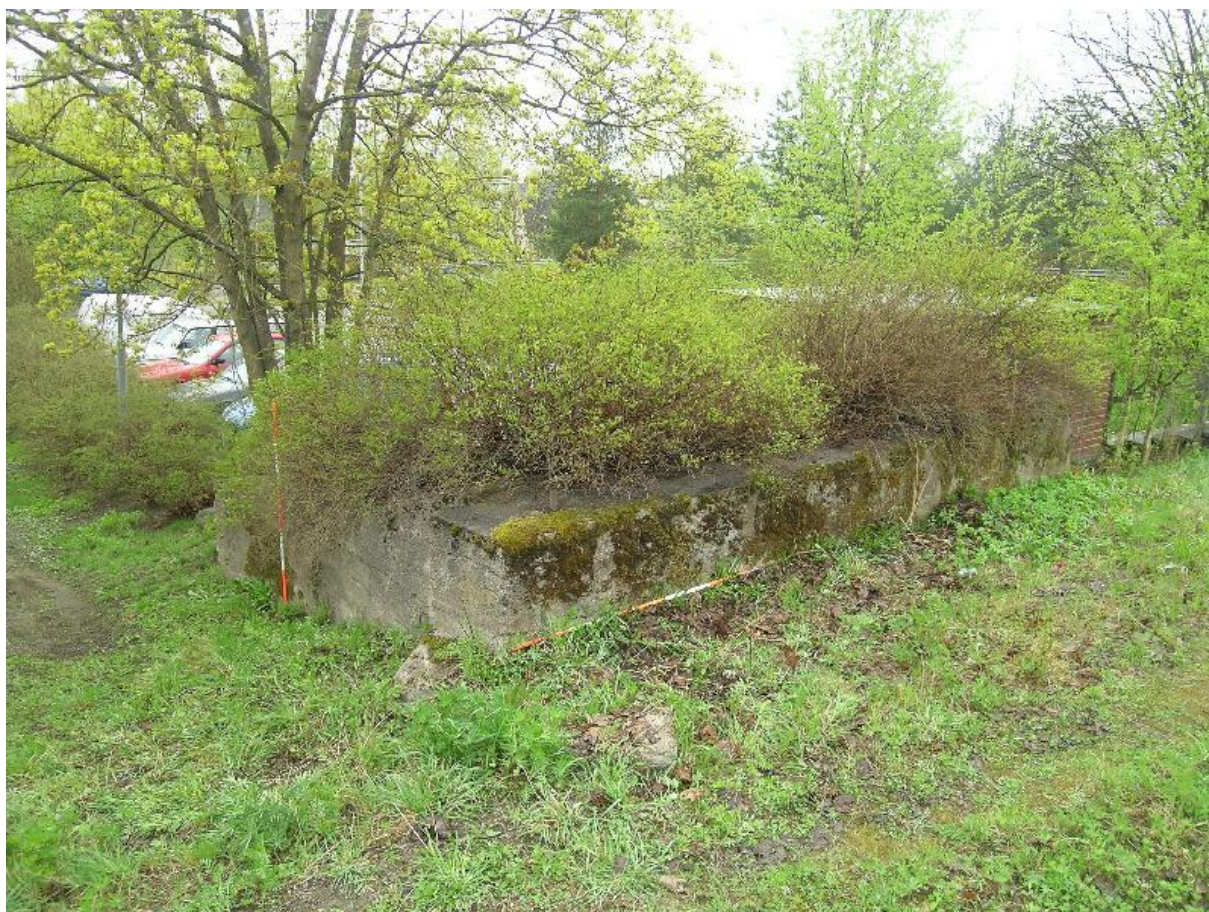
DSCN0303.JPG Pispalan tukkitie 1, betonirakenne. Koillisesta. 7.5.2008, Vadim Adel.
