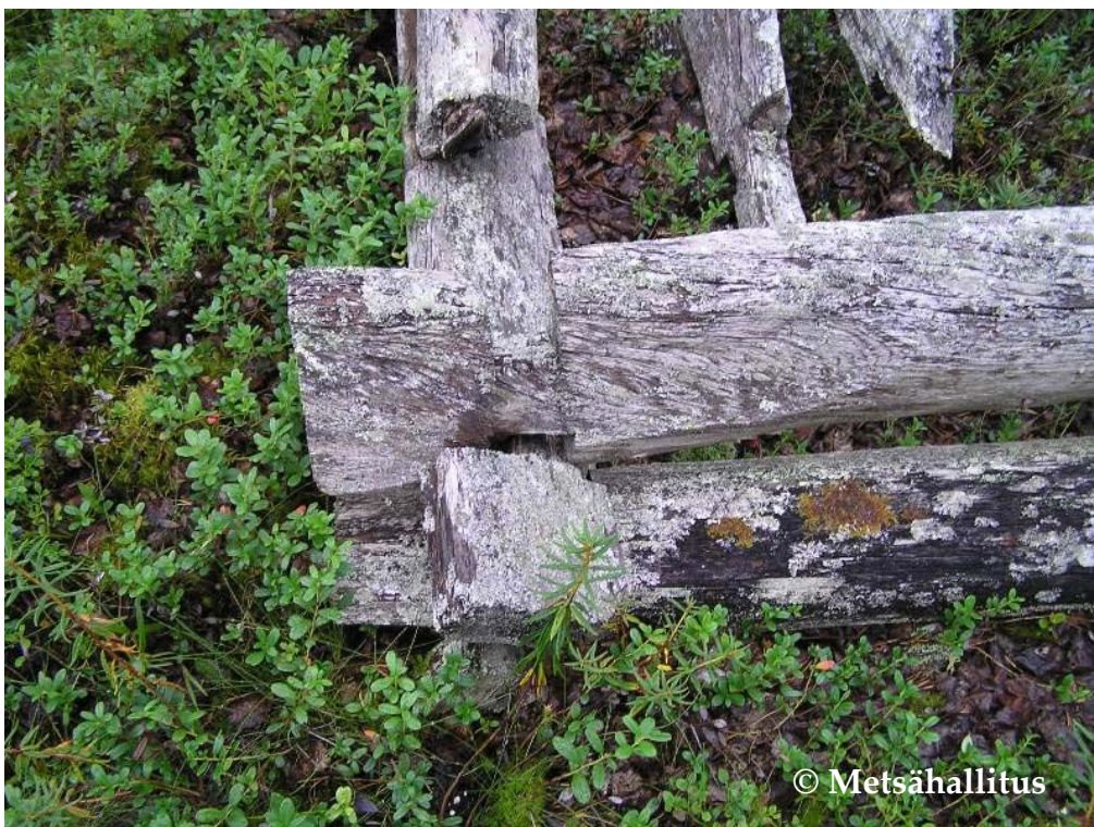
Kuva 24. Iso Arttajärvi 2. Yksityiskohta aitan salvoksista.
