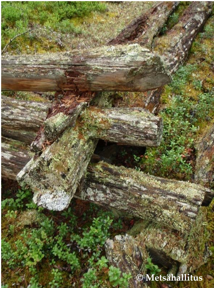
Kuva 22. Talasjärvenlompolat 4. Yksityiskohta savottakämpän hirsisalvoksista.
