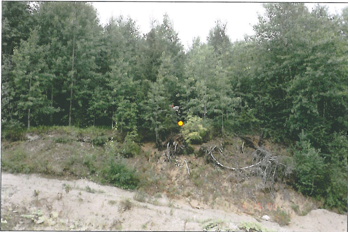
Kuten yläkuva. Kaivausaluetta avataan.
