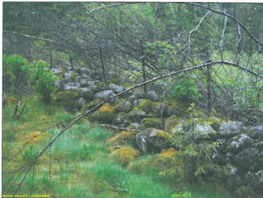
Kiviaitaa voimajohtolinjan alla – vesakkoa kaadettu päälle.
