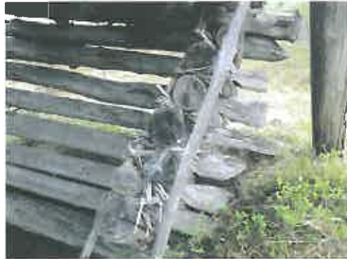
Kuva 80460-52647 Paskalampi niittylato. Oven pielen vitsapunos ylhäältä kuvattuna.
