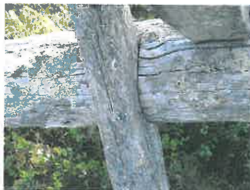
Kuva 80276-52258 Pyöreälampi 3 parkkauspukki. Pukin jalkojen liitos.
