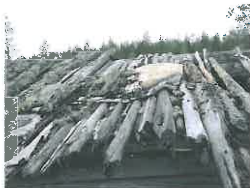
Kuva 80460-52654 Paskalampi niittylato. Katon tuohikatetta, joka on osin lentänyt tuulen mukana ympäristöön.
