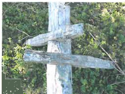
Kuva 80276-52256 Pyöreälampi 3 parkkauspukki. Pukin jalat on kiinnitetty kiilaamalla, kuva ylhäältä.
