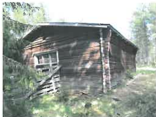
Kuva 80400-52520 Taivalvaara kämppä. Talli kuvattuna etelästä.
