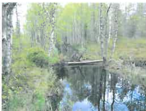
Kuva 80420-52575 Kaivosoja niittypato kuvattuna itään kanavan suuntaisesti.
