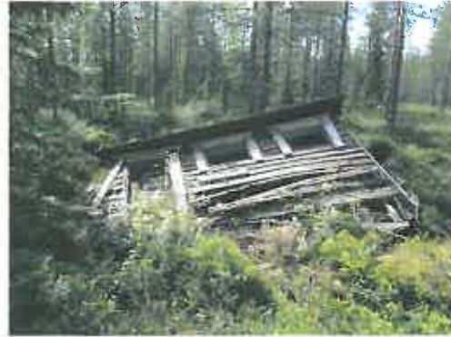
Kuva 80400-52521 Taivalvaara kämppä. WC kuvattuna koillisesta.
