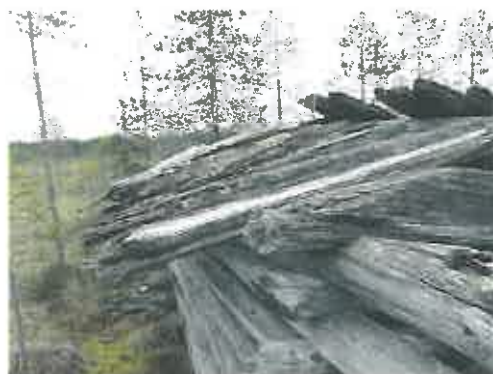
Kuva 80460-52648 Paskalampi niittylato. Ladon halkaistusta puusta ja tuohesta tehty katto.
