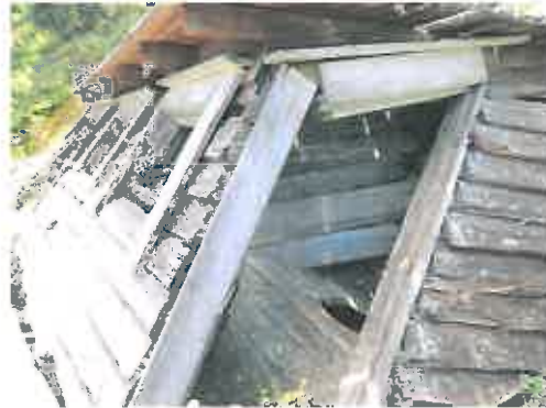
Kuva 80400-52522 Taivalvaara kämppä. WC kuvattuna pohjoisesta.
