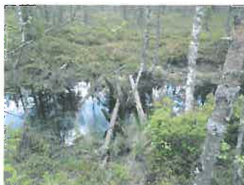
Kuva 80420-52573 Kaivosoja niittypato. Tammen pato kaivetussa kanavassa, kuvattu etelään.
