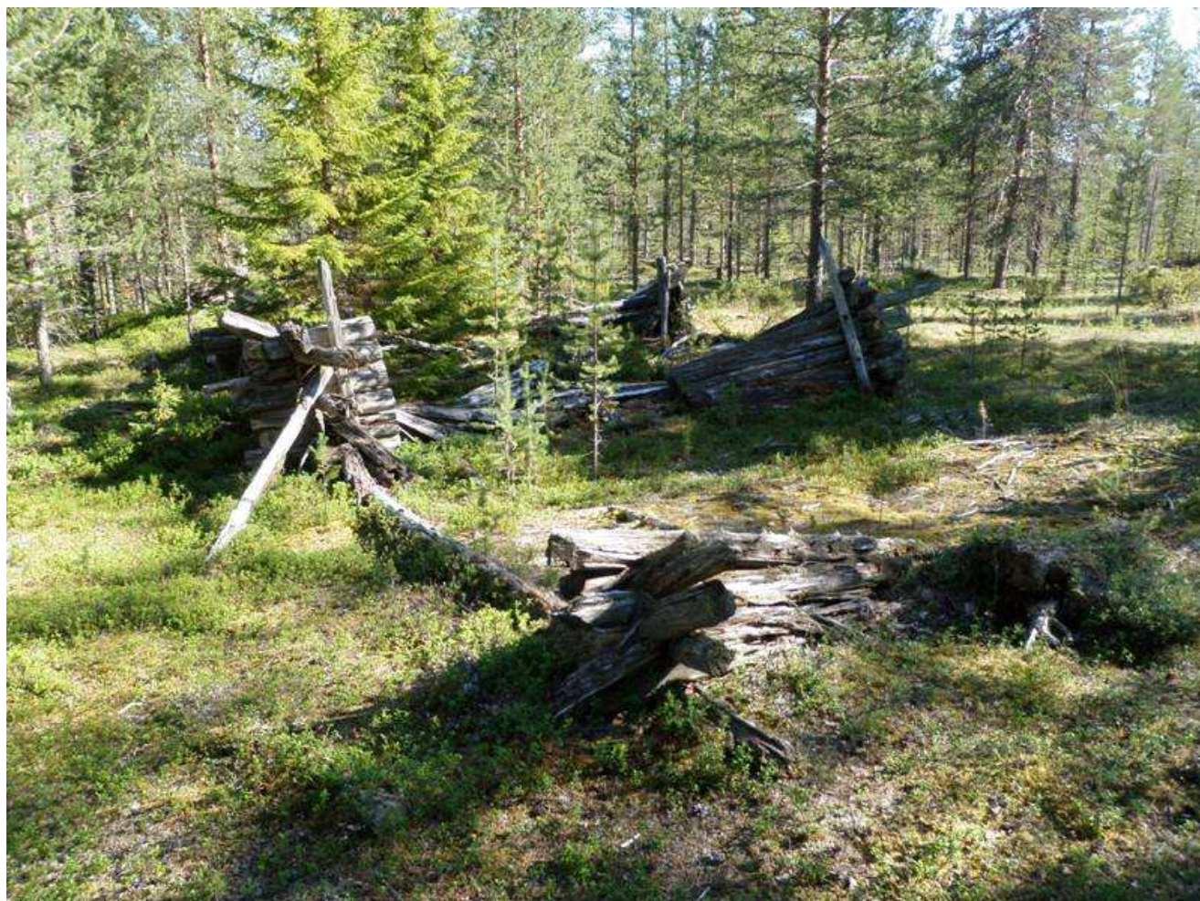
Kämpän hirsiseinien nurkat ovat osittain hyvin säilyneet.
