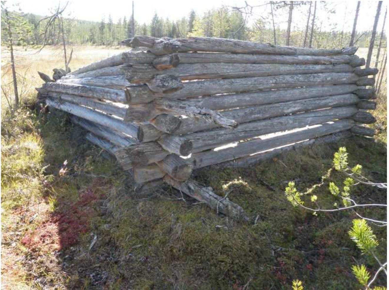
Ladon hirret ovat hyvin säilyneet ja niiden nurkkasalvokset on tehty huolella.
