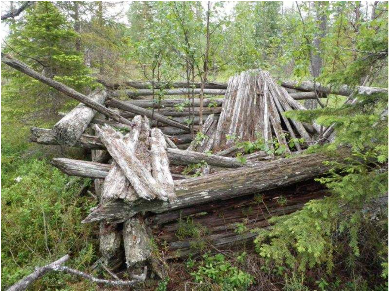
Ladossa on harva hirsiseinä ja katto on tehty kirveellä veistetyistä laudoista.
