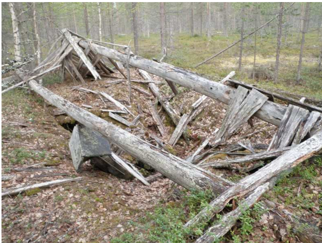
Taimikellarin katto ja vasemman tukipuun alla tuuletushormi.
