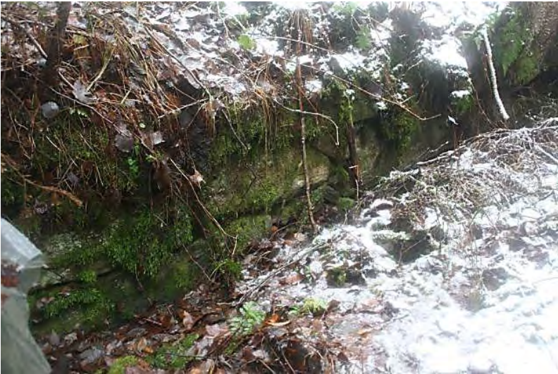
DG2938:2. Vuonna 1889 valmistuneen Savon radan vanhan ratapenkan kivimuuria luoteesta kuvattuna. Kuva Ville Rohiola/Arkeologiset kenttäpalvelut
