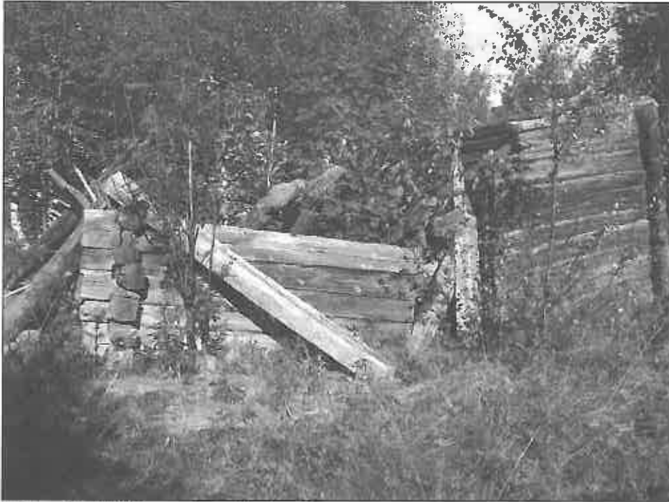
Aitta niityllä (Kuva otettu länteen)
